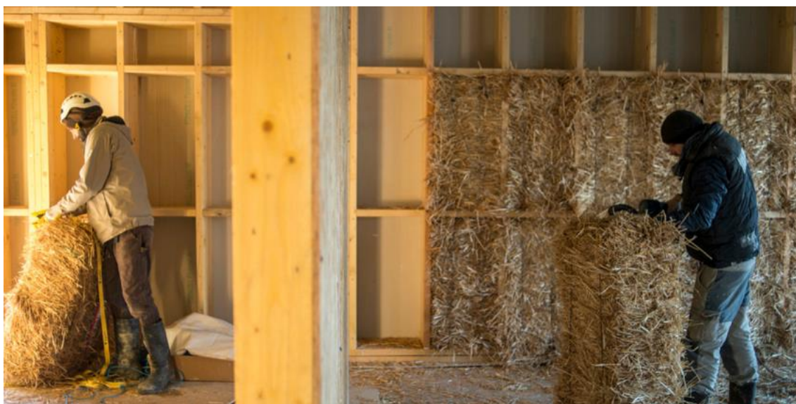
Figura 7 - Isolamento em palha- fotografia Jérôme Derigny, em https://grandhuit.eu/wp-content/uploads/2018/11/FDRpailleDerigny.jpg
