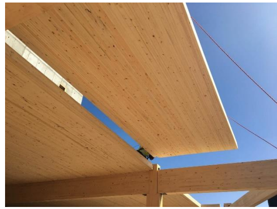
FIGURA 4.5.5: Construção do T3 Minneapolis. Prédio de 7 pisos que utilizou painéis de DLT FONTE: StructuralCraft
