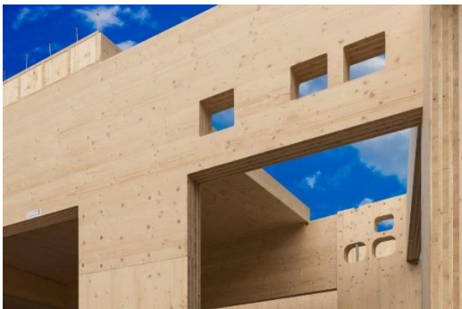
FIGURA 4.2.3: Painéis chegam à obra com vãos já recortados FONTE: Amanu-Invest
