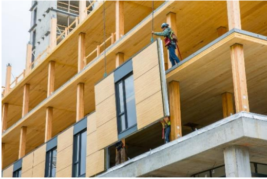
FIGURA 6.4.4: Fachadas do Edifício Brock Commons, no Canadá, em execução FONTE: The Earthbound Report
