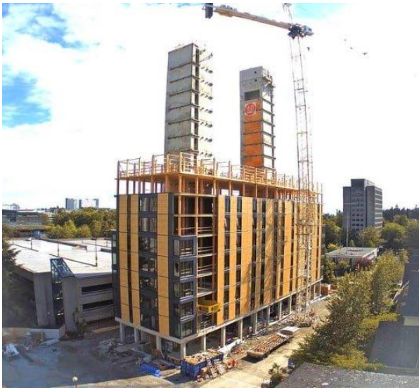
FIGURA 6.4.2: Edifício Brock Commons no Canadá ainda em fase de execução: Fundação e rés de chão em betão armado FONTE: engenheironaweb.com
