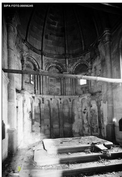
Fig. 15 Interior – dois registos de arcadas na cabeceira © IHRU: DGEMN/DSID IPA.00000287
