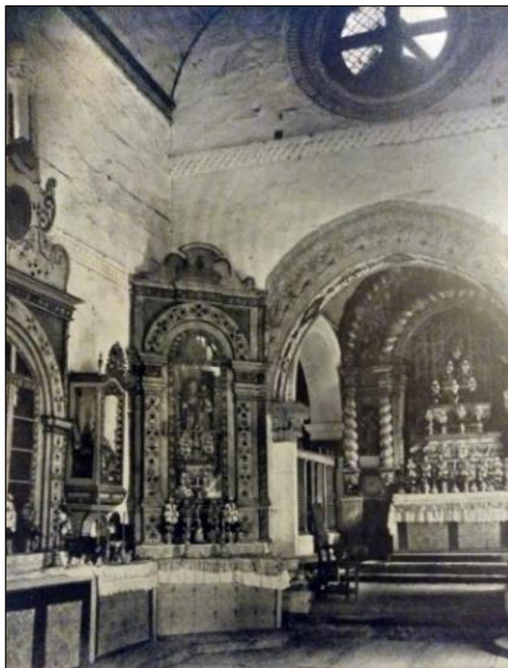
Fig. 12 Vista da nave a capela-mor antes da intervenção © IHRU: DGEMN/DSID IPA.00002175
