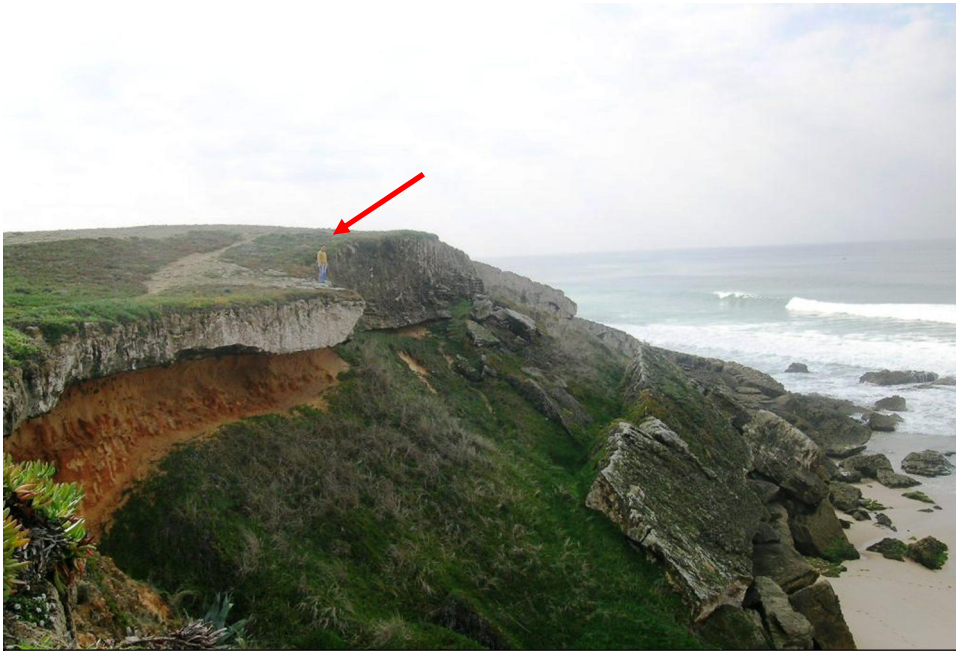
A8 – Desabamento do topo da arriba, constituído por dunas consolidadas (em consola sobre areias cenozóicas friáveis)
