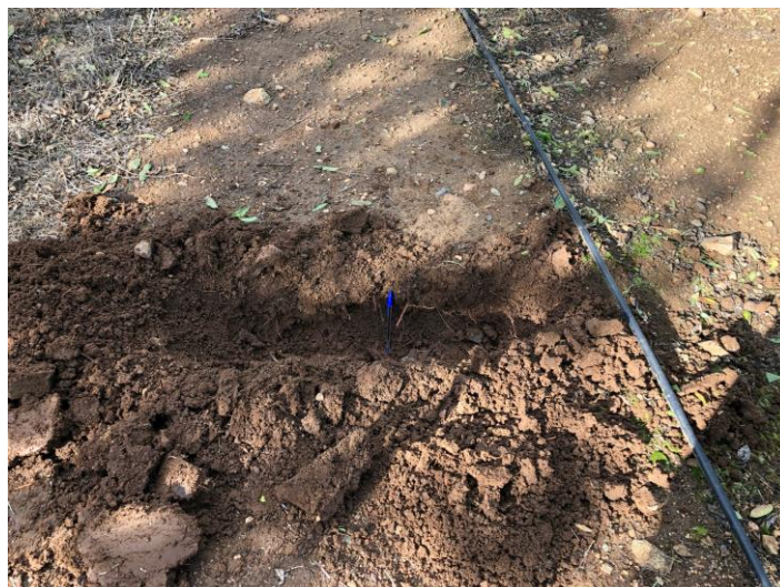
Figura 37 - Abertura de trincheira perpendicular à linha de cultura e correspondente rampa de rega.
