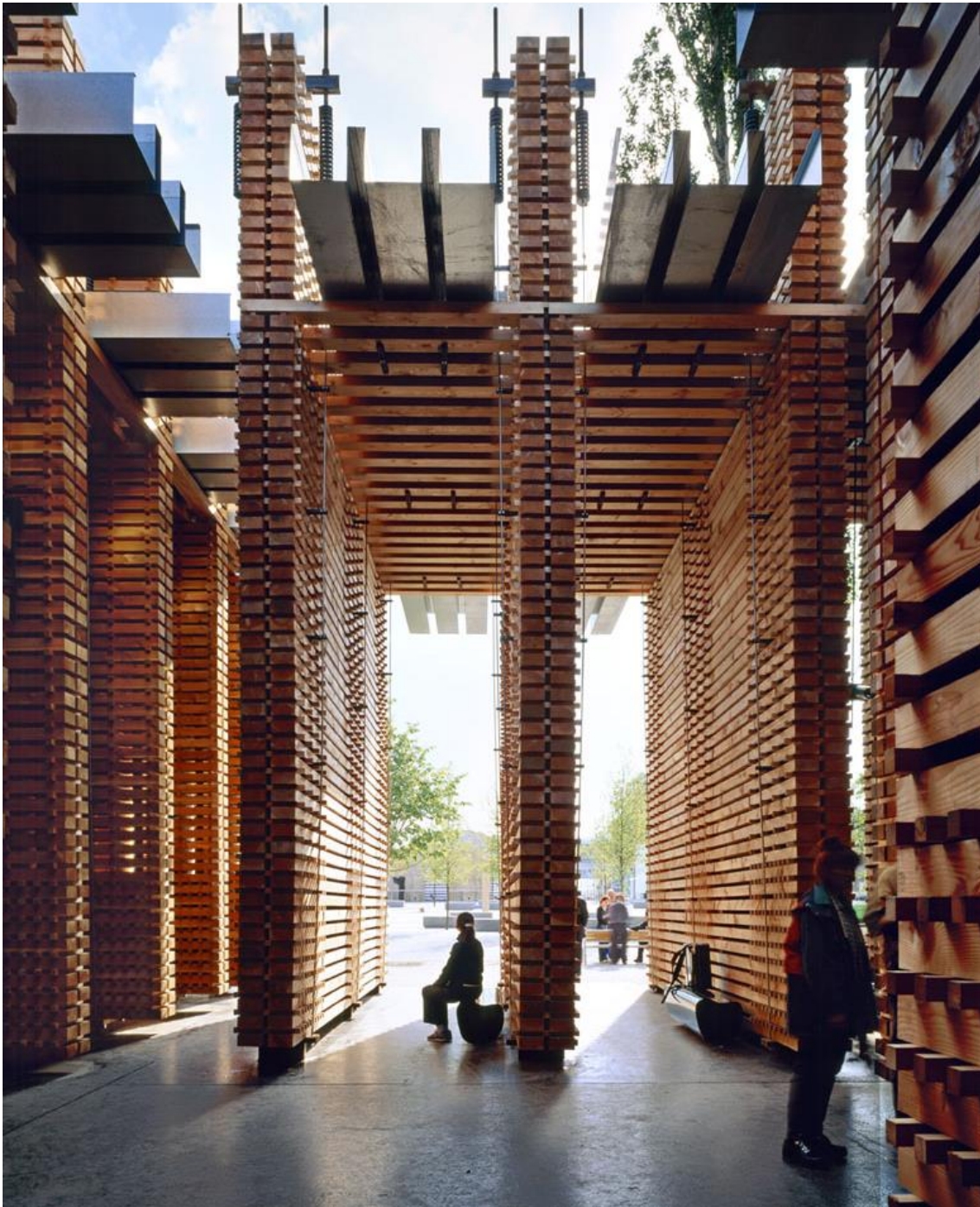
Figura 30– Pavilhão Swiss Sound, Hanover, Alemanha, 2000, Peter Zumthor
