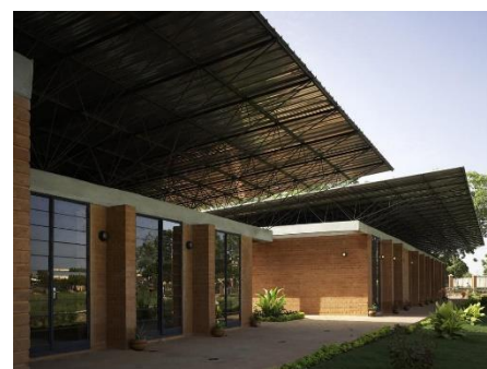
Figura 67 - Cobertura extensa, abriga da chuva e dos raios solares
