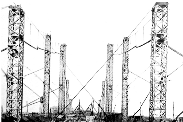
Fig. 4.9. Início da obra da fábrica da General Motors em St Louis, Missouri (in Ransome, 1919: 24).
