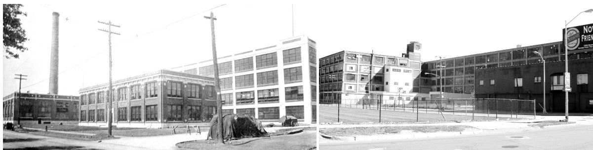
Figs. 4.12 e 4.13. Casa da energia da Messrs. Dodge Brothers em Detroit (in The American Architect , 1911), cerca de 1911 e situação actual.
