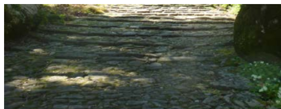
F.15. Calçada em granito na entrada do convento Fonte: autora
