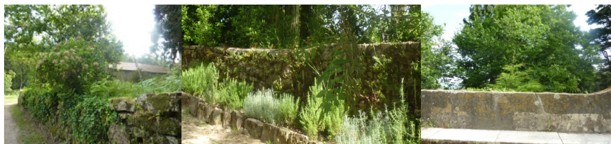
F.18. Muros de suporte das hortas, do "Terreiro da Fonte" e do claustro, da esquerda para a direita. Fonte: autora
