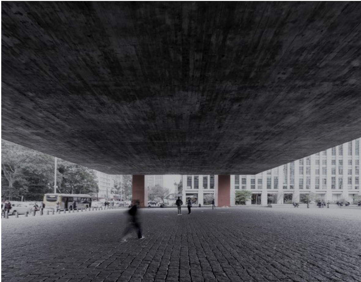
Figura 35 – Museu de Arte de São Paulo, transição por baixo do edifício. Fonte: https://www.archdaily.com.br/br/905090/masp-de-lina-bo-bardi-completa-50-anos . Consultado em: 25/11/2022
