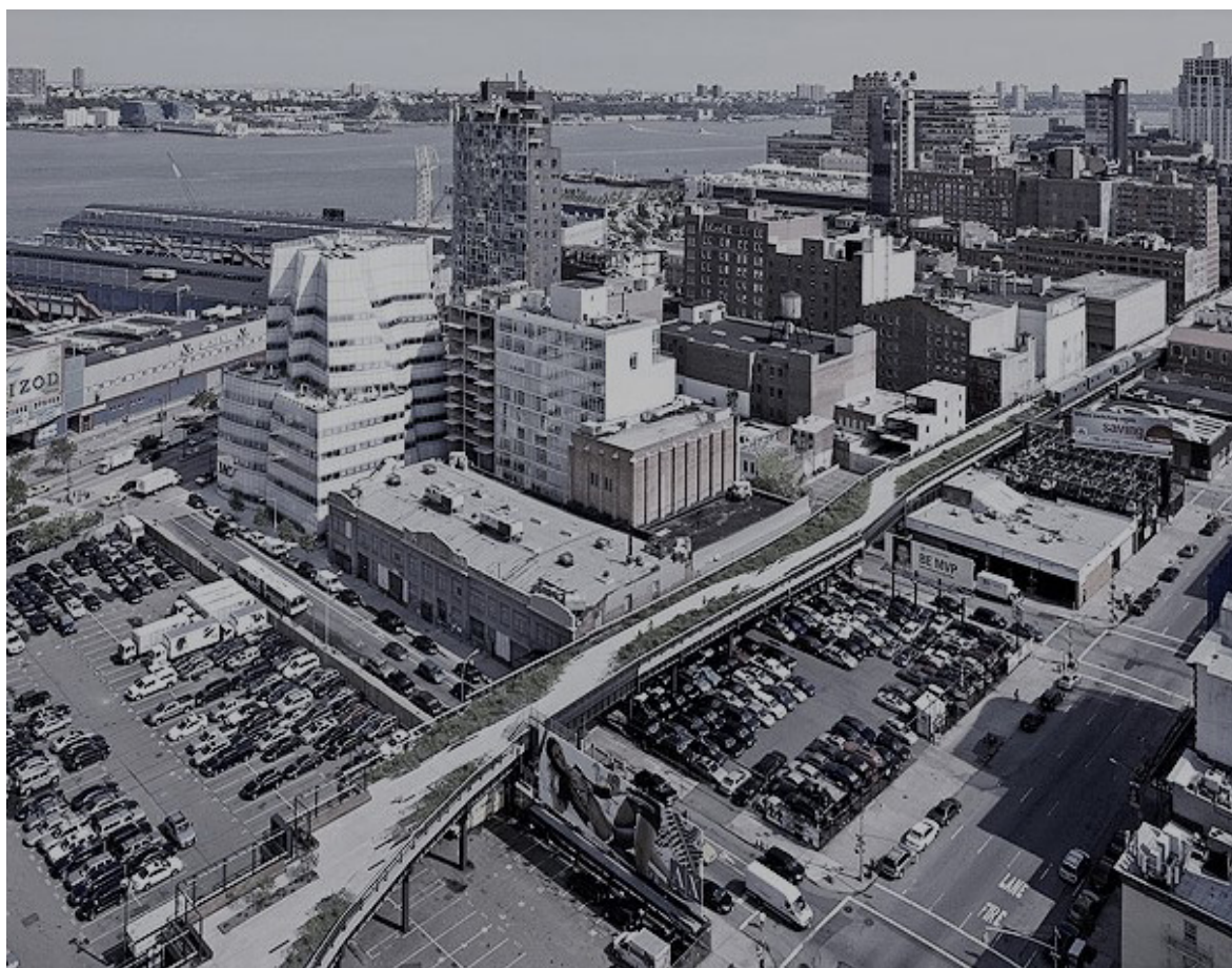
Figura 39 – High Line, vista aérea.
