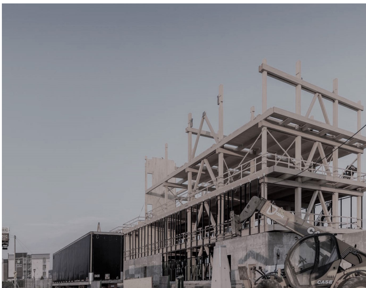
Figura 153 – Estrutura feita de madeira CLT
