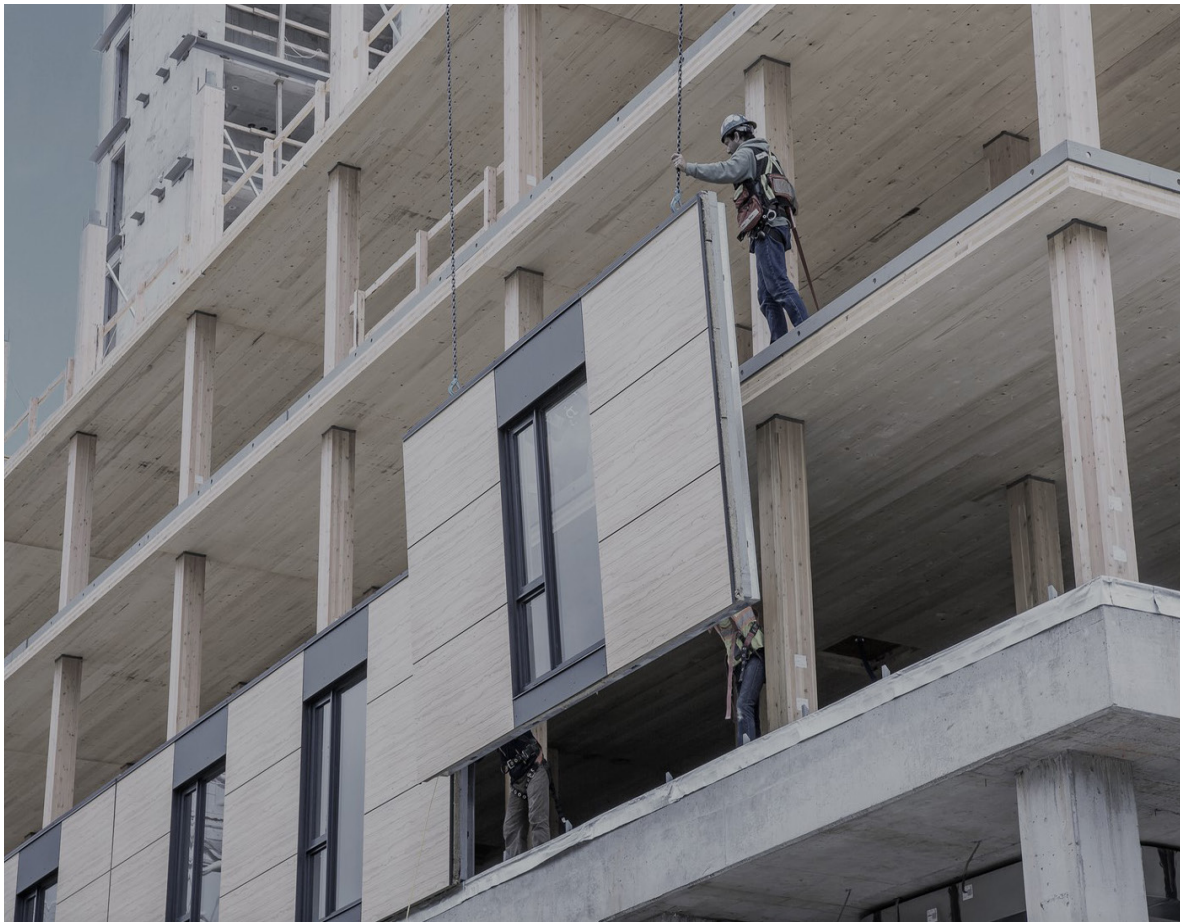
Figura 152 – Montagem das placas de madeira CLT
