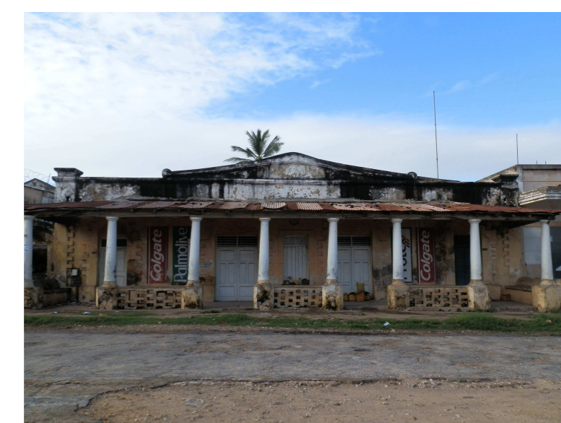
Edifício da zona antiga colonial
