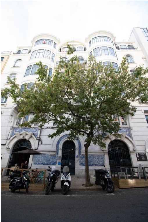
Rua Rodrigues Sampaio, 27-35 Lisboa
