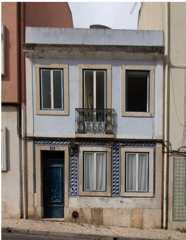
Rua da Arrábida, nº12, Lisboa
