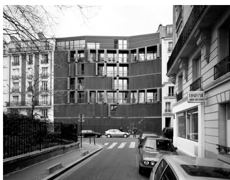
Fig. 26 - Fachada Rue des Suisses.
