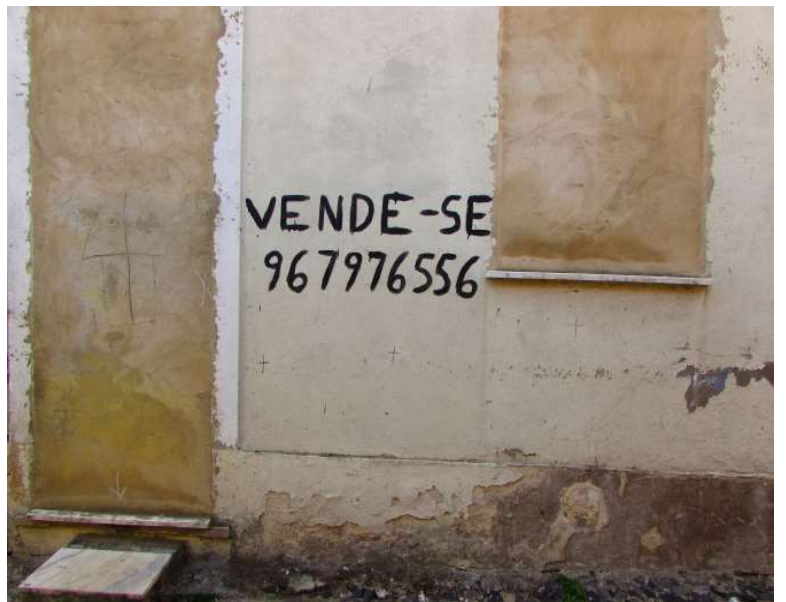
I. Expressão recorrente nas fachadas dos edifícios do bairro
