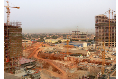
28- Centro de Luanda, permanente Estaleiro de Obras para grandes Empreendimentos
