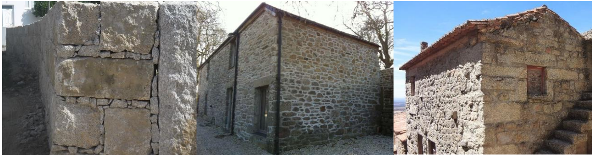
Figura 3.18- Construção em granito: a) muro [65]; b) casa com paredes de granito [66]; c) exterior de uma habitação em Monsanto (Idanha-a-Nova)[67].
