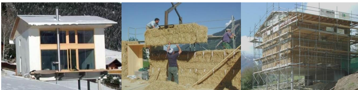
Figura 3.19- Construção em palha: a) exterior de um edifício; b) construção de paredes c) vista exterior da construção [68].
