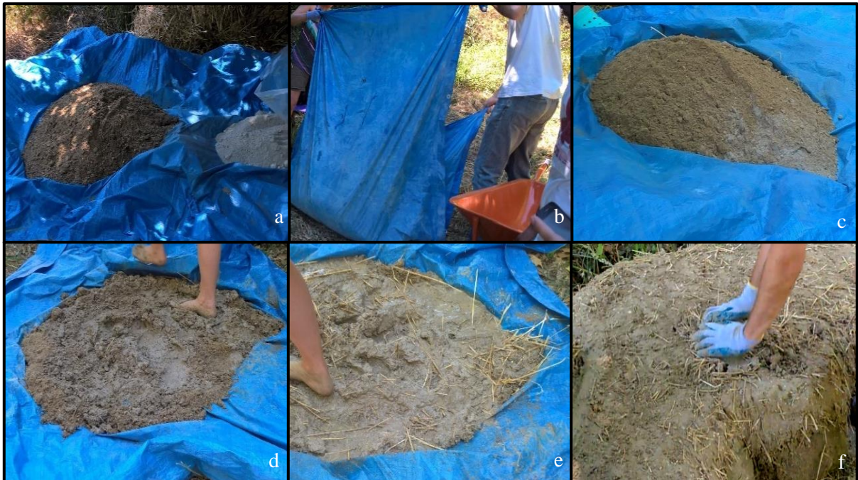
Figura 3.14- Processo “manual” de produção de cob : a) terra e argila; b) e c) mistura de terra e argila; d) adição de água à mistura; e) junção de palha à mistura; f) aplicação na estrutura.
