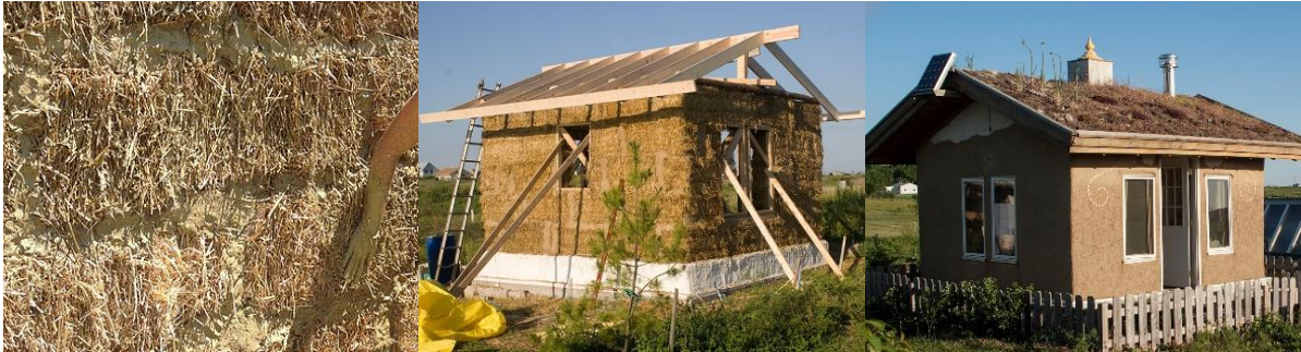
Figura 3.21- Construção com bale cob : a) acabamento com cob [70]; b) processo de construção; c) exterior de uma habitação [71].
