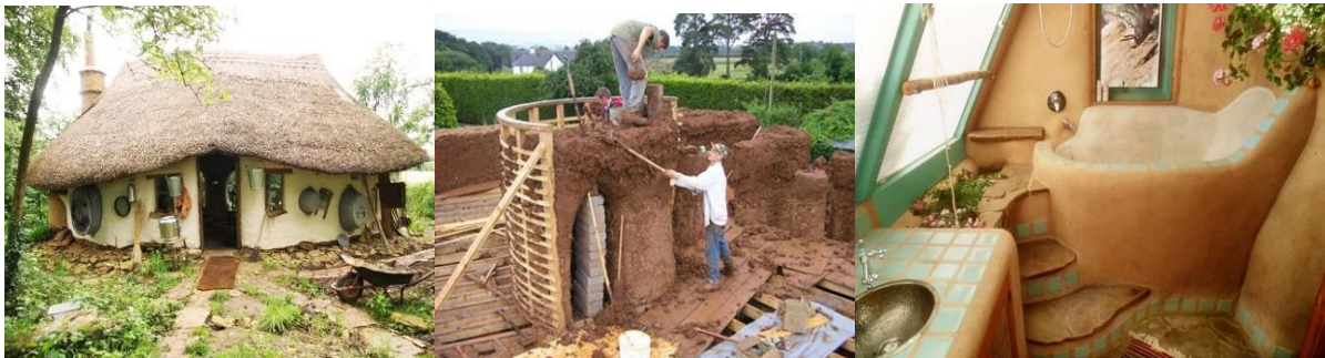
Figura 3.20- Construção em cob : a) exterior de uma habitação; b) construção de paredes; c) casa-de-banho [69].
