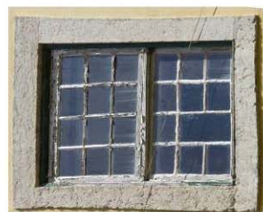
Rua São Nicolau nº 12
