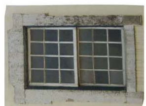
Rua São Nicolau nº 12
