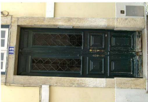
Travessa de João de Deus nº 13
