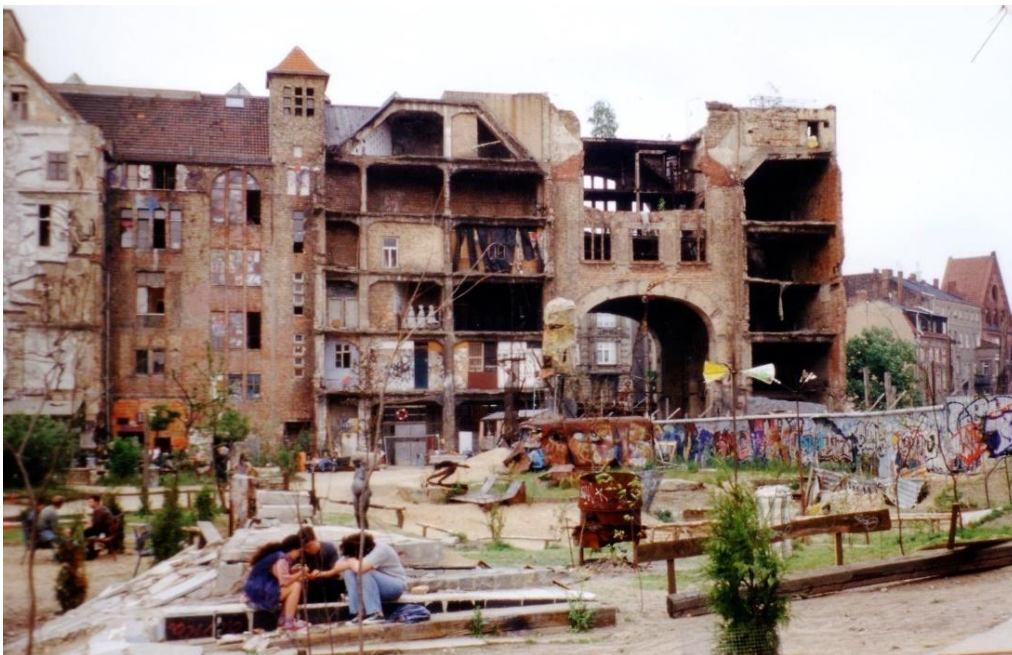
Figura 23 Centro cultural Tacheles, Berlim, maio, 1995. Construído em 1908 como uma loja de departamentos, foi demolido parcialmente durante a 2ª Guerra e, após a queda do Muro, passou a ser utilizado temporariamente como um centro artístico informal. Foto: Traumrune CC-BY-SA-3.0.
