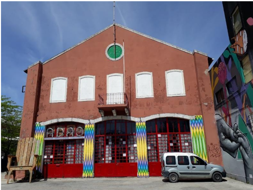
Figura 61 Fachada das instalações da Associação ADAO, Barreiro. Foto: próprio autor, 2018.
