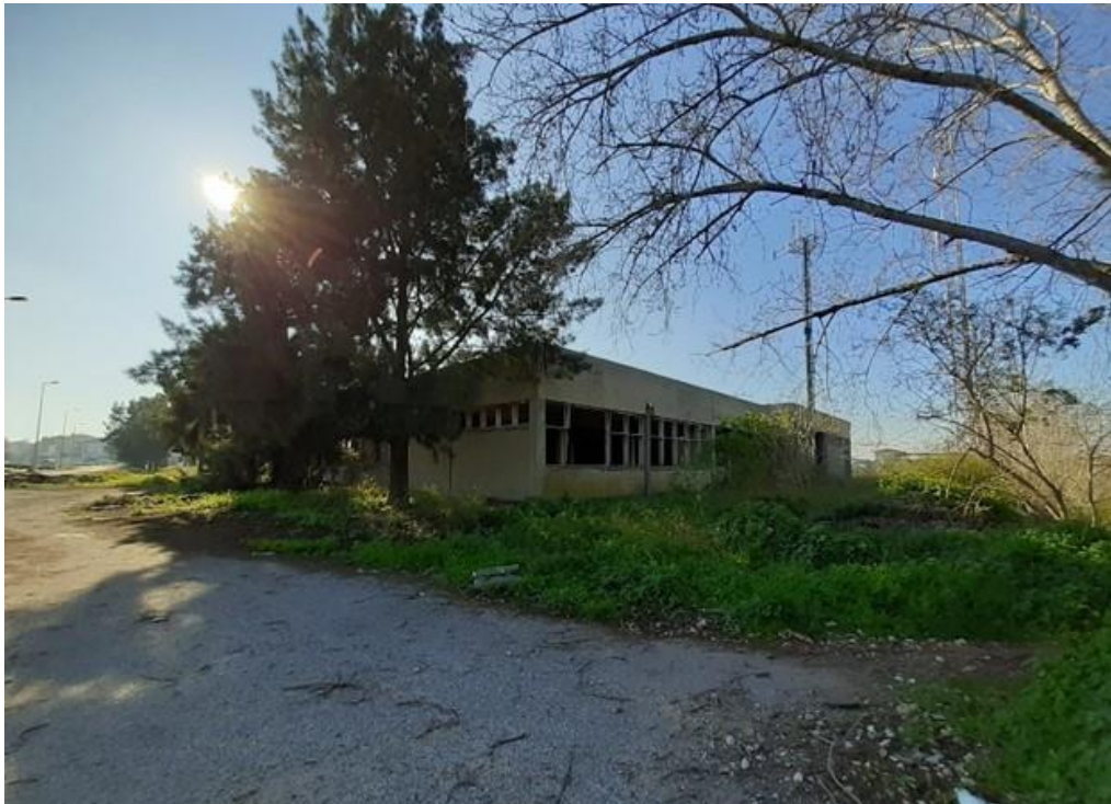
Figura 83 Fotografia da área exterior, incluindo a edificação (antigo armazém industrial). Fonte: Autor, dezembro 2019
