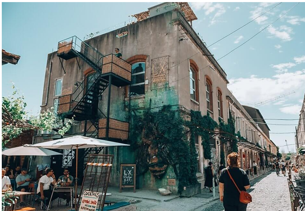
Figura 24 LX Factory - Lisboa. O espaço voltado principalmente para o turismo, as artes e o lazer, nasceu em 2005 diante da inércia dos projetos de regeneração previstos para toda a área de Alcântara. A partir do reuso intermédio de antigas instalações industriais que remetem ao séc. XIX, a LXF tornou-se o local mais “hipster” de Lisboa (Le Mans, 2022) atraindo novos investidores e novos grupos de pessoas. Em 2021 teve parte de suas estruturas demolidas para a futura implementação de um novo projeto imobiliário. Foto: Website LXFactory https://lxfactory.com/en/the-dorm-2-2/ acesso em 01/02/2023
