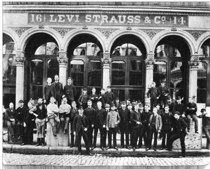
Figura 34 Production site of Levi Strauss & Co in San Francisco in 1882 | Fonte: Gettyimages.pt (consultado a 29 de julho, 2024)
