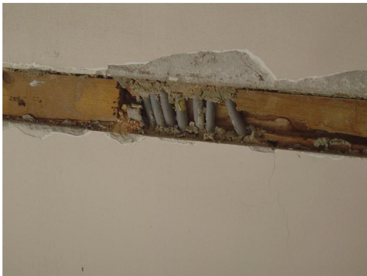
Fig. VII -13: Palácio Ribeira, fotografias obtidas na visita ao imóvel em Março de 2009. Sondagens in loco . Fotografia de autor.
