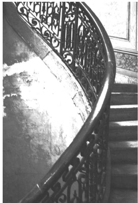
Fig. XV -10: Palácio Ribeira, Pormenores a conservar: guardas da escadaria principal. Fotografia cedida para fins académicos pela Arqt. a Fernanda Castelo.
