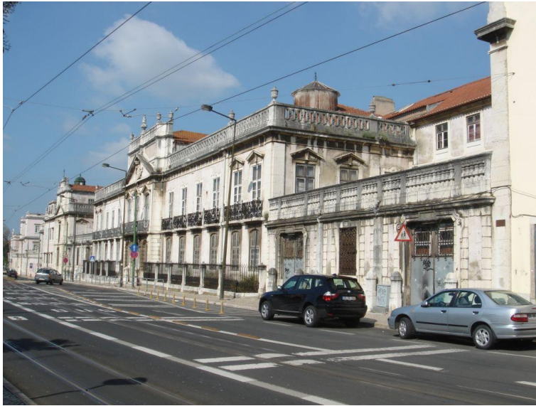
Fig. II -1: Palácio Ribeira, Alçado Sul (Rua da Junqueira). Fotografia cedida para fins académicos pelo Grupo Fibeira Engenharia e pelo Prof. Arqt.º José Afonso.
