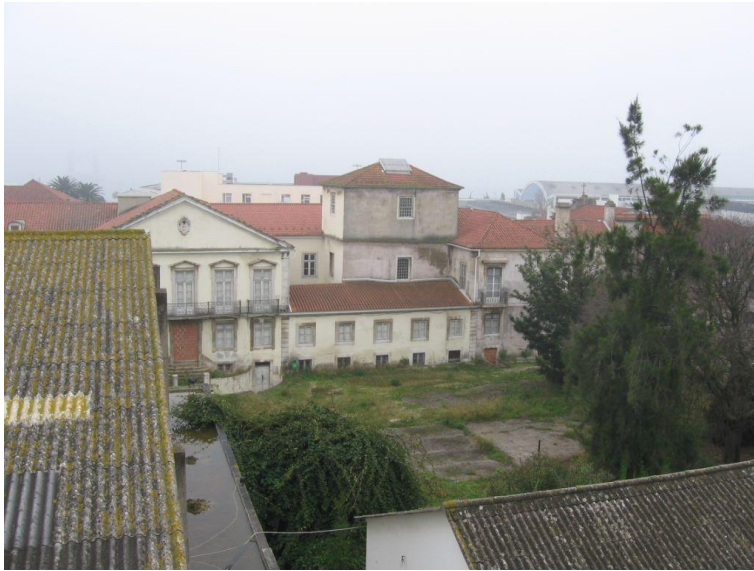
Fig. III -1: Palácio Ribeira, Alçada Norte (jardim). Fotografia cedida para fins académicos pelo Grupo Fibeira Engenharia e pelo Prof. Arqt.º José Afonso.
