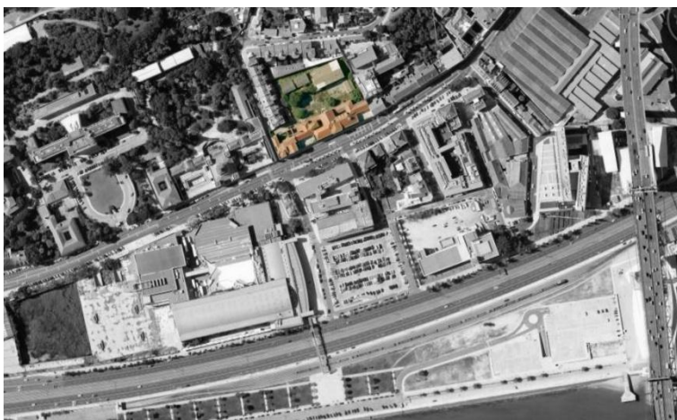
Fig. I -2: Vista aérea da Rua da Junqueira, Belém. Fotografia sem escala – Google Earth.
