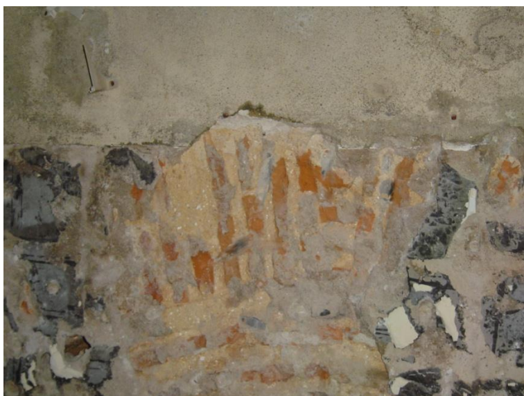
Fig. VII -8: Palácio Ribeira, fotografias obtidas na visita ao imóvel em Março de 2009. Sondagens in loco . Fotografia de autor.
