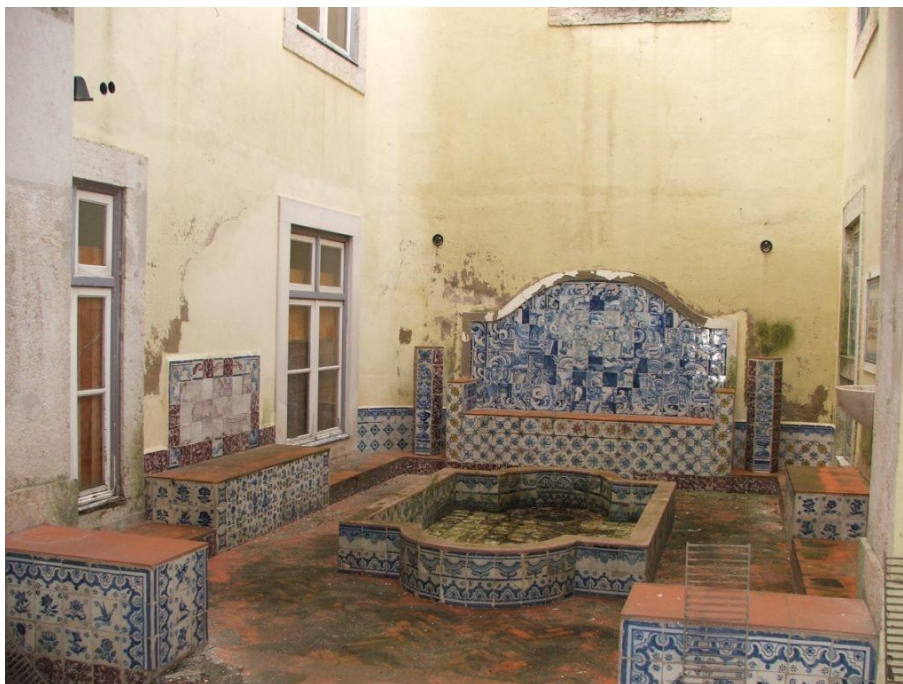
Fig. XI: Fotografia in loco da intervenção no pátio do piso térreo, pela Arquitecta Fernanda Castelo. Fotografia cedida para fins académicos pelo Grupo Fibeira Engenharia e pelo Prof. Arqt.º José Afonso.
