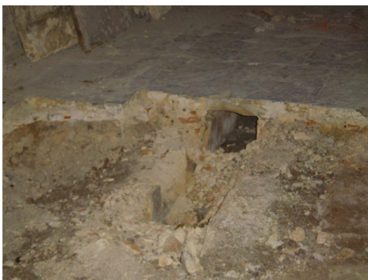
Fig. VII -17: Palácio Ribeira, fotografias obtidas na visita ao imóvel em Março de 2009. Sondagens in loco . Fotografia de autor.
