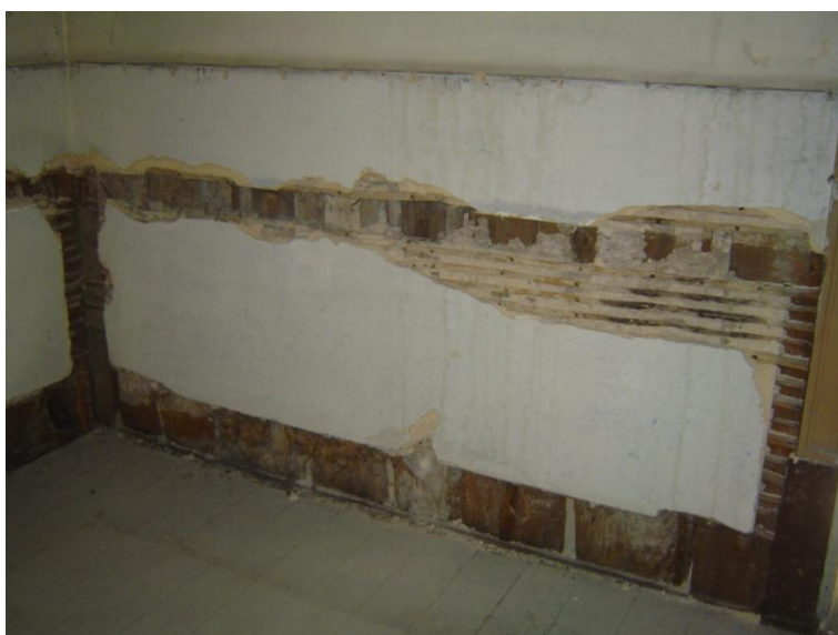
Fig. VII -15: Palácio Ribeira, fotografias obtidas na visita ao imóvel em Março de 2009. Sondagens in loco . Fotografia de autor.
