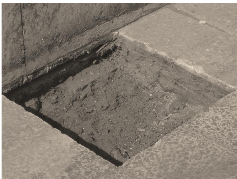
Fig. VII -18: Palácio Ribeira, fotografias obtidas na visita ao imóvel em Março de 2009. Sondagens in loco . Fotografia de autor.
