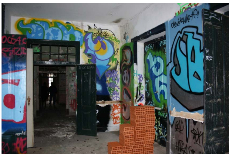
Fig. XVII -2: Palácio Ribeira, fotografias obtidas na visita ao imóvel em Março de 2010. Situação actual: Suite Mobilidade Condicionada, 1º piso (nobre). Fotografia de Maria Torres Campos.
