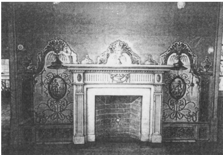
Fig. XV -6: Palácio Ribeira, Pormenores a conservar: fogão de sala integrado em lambrim. Fotografia cedida para fins académicos pela Arqt. a Fernanda Castelo.
