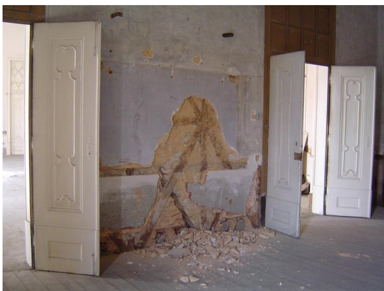
Fig. VII -14: Palácio Ribeira, fotografias obtidas na visita ao imóvel em Março de 2009. Sondagens in loco . Fotografia de autor.
