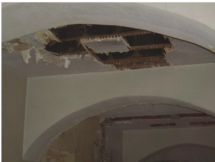
Fig. VII -7: Palácio Ribeira, fotografias obtidas na visita ao imóvel em Março de 2009. Sondagens in loco . Fotografia de autor.
