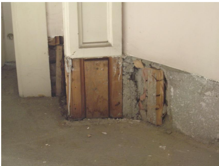
Fig. VII -11: Palácio Ribeira, fotografias obtidas na visita ao imóvel em Março de 2009. Sondagens in loco . Fotografia de autor.
