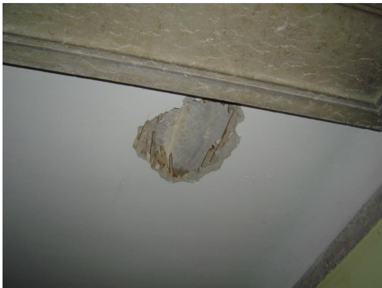
Fig. VII -16: Palácio Ribeira, fotografias obtidas na visita ao imóvel em Março de 2009. Sondagens in loco . Fotografia de autor.
