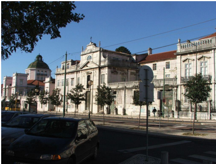
Fig. II -2: Palácio Ribeira, Alçado Sul (Rua da Junqueira). Fotografia cedida para fins académicos pelo Grupo Fibeira Engenharia e pelo Prof. Arqt.º José Afonso.
