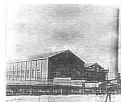
Fig. 34 Em 1901 a Companhia de Carris de Lisboa Constrói a própria central. A Geradora de Santos, Vista Geral. Foto do Arquivo Histórico da Companhia de Carris de Lisboa, registo n.º 84. B. 496.
