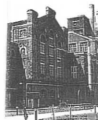
Fig. 140 Alçado Norte da sala das máquinas. Foto, Maria Luisa Freiria e Maria Odete Ferreira, A Central Tejo, Lisboa, 1997, foto n.º 26.
