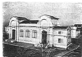
Fig. 47 Foto do edifício Aquário Vasco da Gama, s/autor, data 1898. Espólio da “Casa Touzet”.
