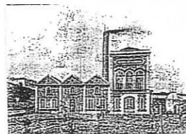
Fig. 18 Estação Elevatória de Água dos Barbadinhos. Inauguração da chegada das águas do Alviela a Lisboa.. "Abastecimento de Águas em Lisboa", in O Ocidente. Revista Ilustrada de Portugal e do Estrangeiro, vol. III, n.º 70, 15 de Novembro 1880, Lisboa, pp. 186-187.
