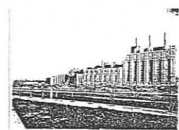
Fig. 86 Central Tejo III. Foto de Kurt Pinto. Arquivo das CRGE. Arquivo do “Museu da Electricidade”
