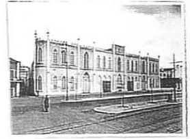
Fig. 55 Foto do alçado Sul da central de electricidade da Boa Vista. Fotografia de Kurt Pinto., s.d. Arquivo do "Museu da Electricidade"
