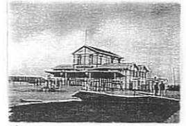
Fig. 58 Foto do edifício da Estação da Parceria dos Vapores Lisbomenses, Datado de 1905. Fotografia do Espólio da “Casa Touzet”
