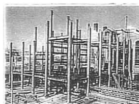
Fig. 41 Edifício das caldeiras de alta pressão. Montagem da estrutura metálica. Foto de Kurt Pinto, data de 1938-39. Arquivo do “Museu da Electricidade”.
