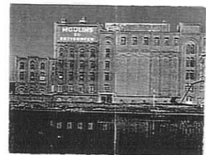
Fig. 80 Moulins de Ruysbroeck., localizado em Brabant. Adriaan Linters, Industria-Architecture Industrielle en Belgique , 1986
