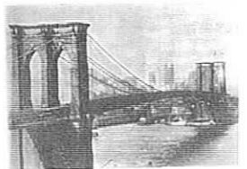
Fig. 104 A ponte de Brooklyn, executado por John A. Roebling (1867-1873). Leonardo Benevolo, História da Arquitectura moderna , Brasil, 1994, p. 229.
