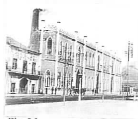
Fig. 26 Fachada Sul da Boa vista., Arquivo Fotográfico da C.M.L..
