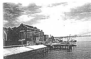
Fig. 135 Alçado Sul da sala das caldeiras de baixa pressão. Foto, Maria Luisa Freiria e Maria Odete Ferreira, A Central Tejo, Lisboa, 1997, foto n.º 25.
