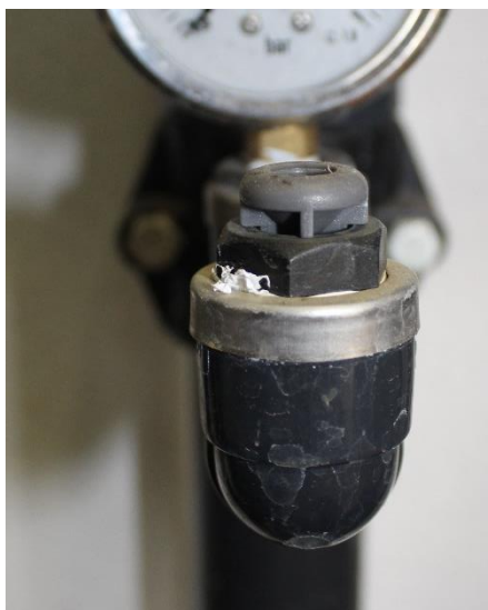
Figura 18 - Válvula Anti-vácuo ou ventosa.
