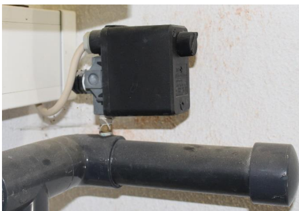
Figura 19 – Pressostato.
