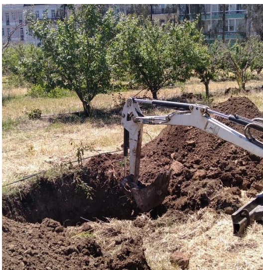
Figura 7 – Abertura do perfil do solo.
