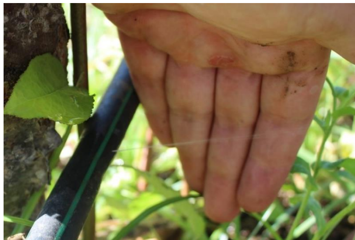
Figura 27 -Furo no tubo de uma das rampas do pomar.
