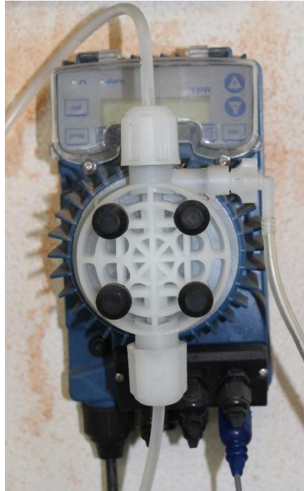
Figura 20 – Bomba doseadora de corretores de pH da água.
