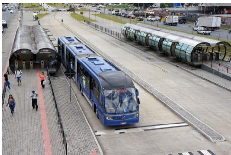
FIGURA 2.14 Estação Marechal Floriano - Linha Verde Curitiba BRT Estação-tubo e ônibus biarticulado, ícones do primeiro sistema BRT do mundo, implantado em Curitiba, Paraná, na década de 1970 in Wikipédia
