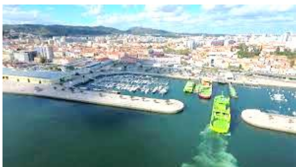
FIGURA 4.50 Estação Fluvial do Cais do Comércio Operado pela Atlantic Ferries – Tráfego Local, Fluvial e Marítimo, S.A in google
