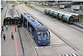
FIGURA 2.22 Estação Marechal Floriano - Linha Verde Curitiba BRT Estação-tubo e ônibus biarticulado, ícones do primeiro sistema BRT do mundo, implantado em Curitiba, Paraná, na década de 1970 de Wikipédia
