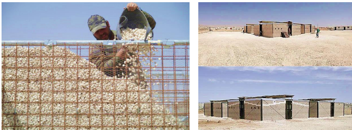
Fig. 51 – (A e B) Solução arquitectónica “RE: BUILD”. Fotos: Pilosio Building Peace, 27 Julho 2015 (Adaptado, disponível em; http://www.archdaily.com/770749/escuelas-modulares-de-andamios-y-arena-permiten-educar-a-los-ninos-refugiados-en-jordania , consultado em 27 Maio 2016).
