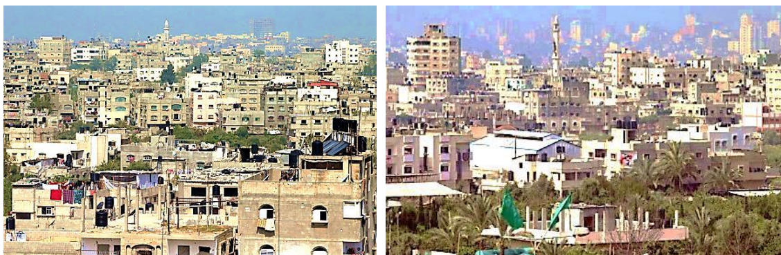
Fig. 20 – (A e B) Vista aérea parcial de campo de refugiados Jabalia , nordeste de Gaza Strip, Faixa de Gaza. Foto: Thomas Coex, 31 Março 2011 (Adaptado, disponível em: [A] http://www.gettyimages.pt/detail/fotografia-de-not%C3%ADcias/partial-view-of-the-jabalia-refugee-camp-fotografia-de-not%C3%ADcias/111292601 ; [B] http://www.gettyimages.pt/detail/fotografia-de-not%C3%ADcias/partial-view-of-the-jabalia-refugee-camp-fotografia-de-not%C3%ADcias/111292677 , consultado em 23 Março 2016).
