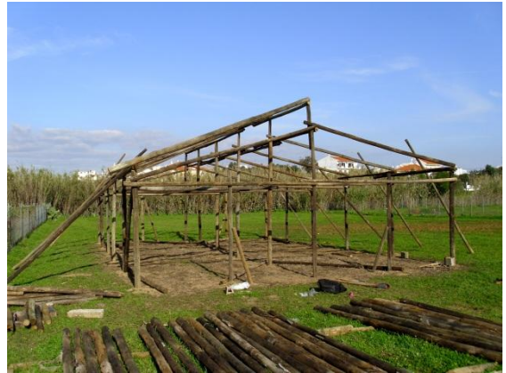
Fig. 17 - Construção da estufa
