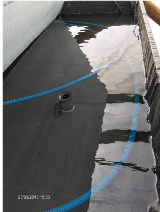
Fig. 38 - Tubo PE corrugado de 16mm. Dissipação de calor na mesa de crescimento
