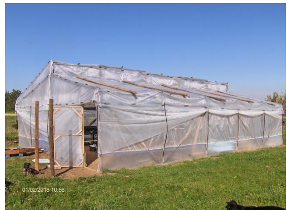
Fig. 39 - Abertura das janelas laterais
