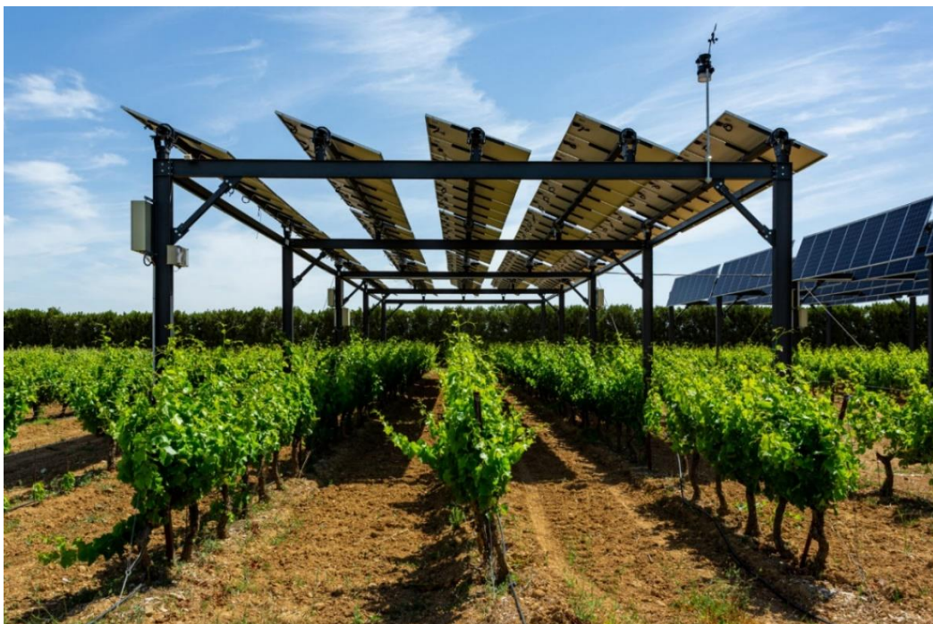
Figura 2.9 – Sistema agri-PV instalado numa região vitivinícola em Piolenc, França [65].
