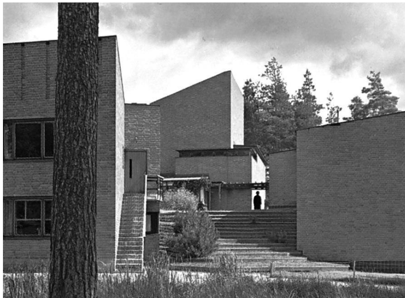
Figura 27 - Fotografia do lado Oeste do conjunto de Säynätsalo. FONTE: http://www.britannica.com/bsp/media-view/34845/1/0/0
