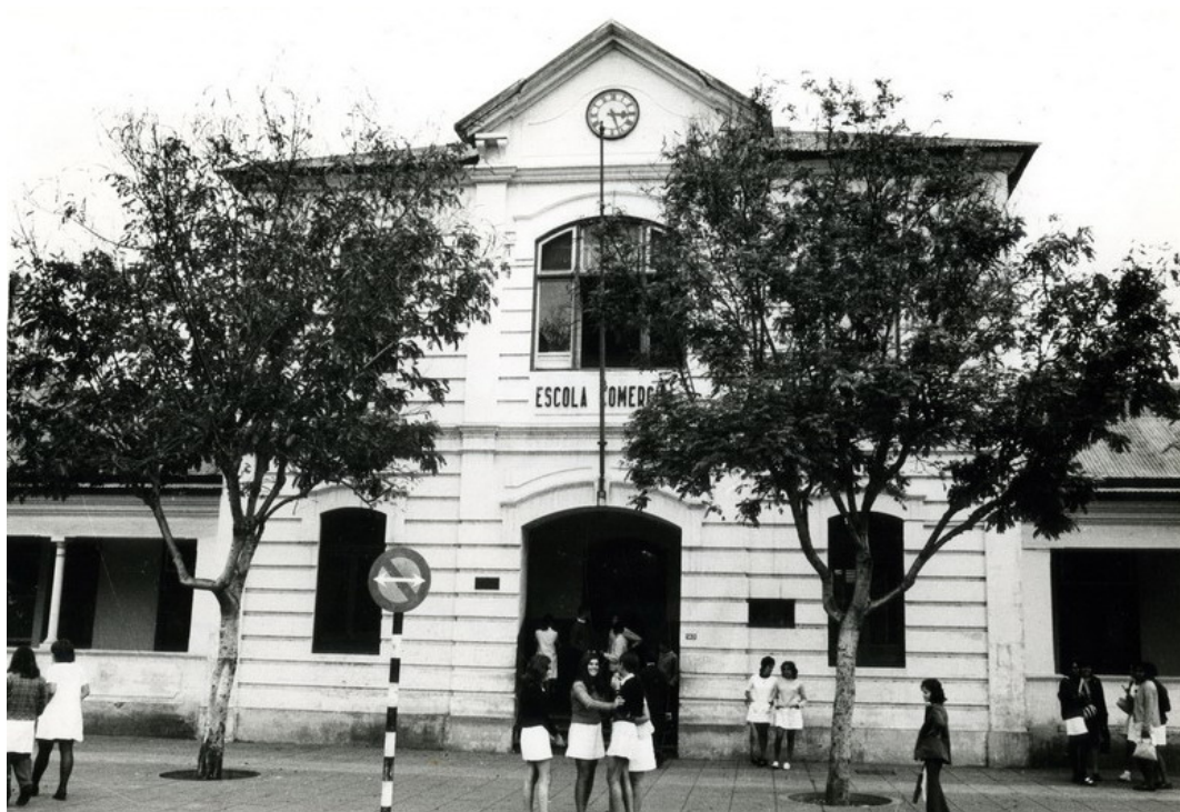
Figura 4- Fachada da Escola Comercial Início dos anos 70
