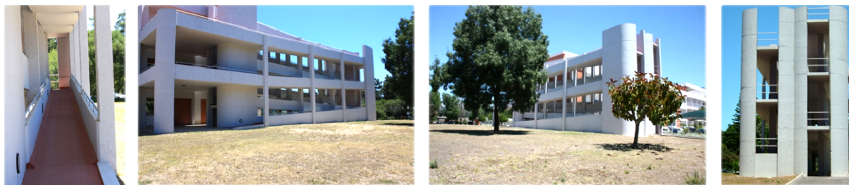
Figura 6 – Fotografias da rampa de emergência das enfermarias do lado Oeste do CMRA (Taborda, 2010).
