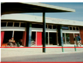
Figura 12 – Rampa de acesso à entrada do edifício principal (Arruda, 2006).
