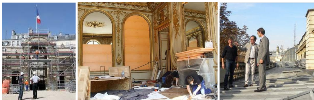
Fig.184, 185 e 186. Michel Goutal em obra de restauro da fachada e interior. Vistoria à cobertura do Eliseu
