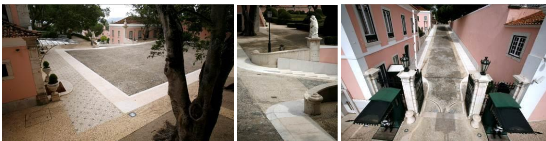
Fig.79 e 80. Pátio dos Bichos com o tapete de calçada, e ligação dos degraus à moldura de pedra.
