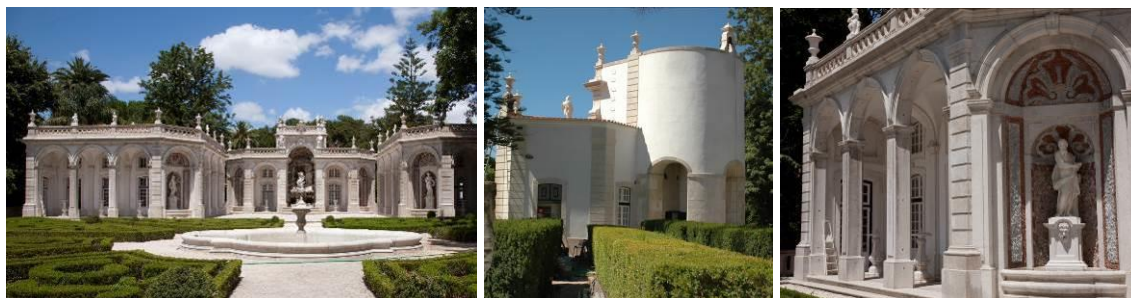
Fig.88 e 89. Viveiros da Cascata restaurados, com rebocos de cal em branco no alçado Norte.
