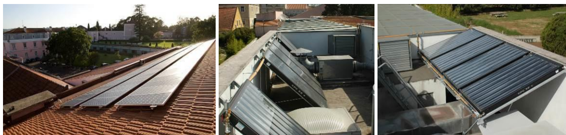
Fig.82. Instalação de 126 painéis solar fotovoltaicos na cobertura da garagem velha.
