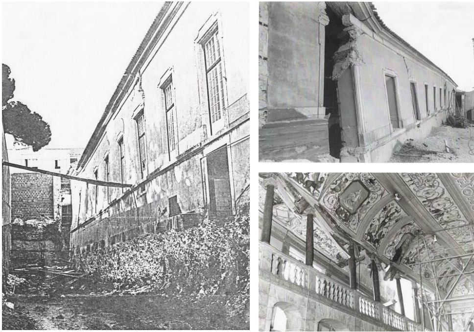
Fig.45. Escavação e parede com fundação descalça. Fig. 46 e 47. Imagens da derrocada de Maio de 1975
