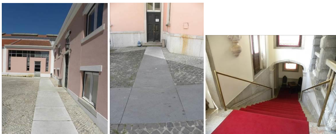
Fig. 111 e 112. Passadeiras lisas entre edifícios, respeitando o material existente. Fig. 113. Corrimãos em latão
