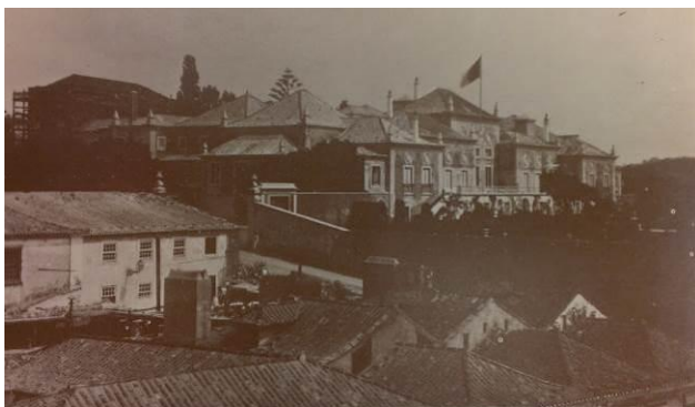
Fig. 17. Palácio no tempo do Rei D. Carlos, onde se reconhecem os andaimes no atelier da Arrábida.
