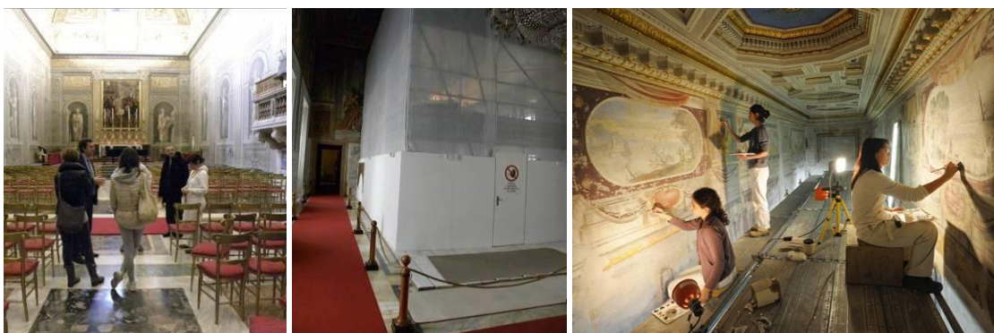
Fig.175, 176 e 177. Reuniões com conservadores-restauradores. Estaleiro no circuito de visitas. Em trabalhos.
