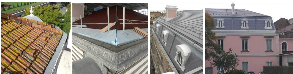
Fig.91. Telhado antes da intervenção. Fig.92 e 93. Aplicação de isolamento térmico, subtelha, linha de vida.
