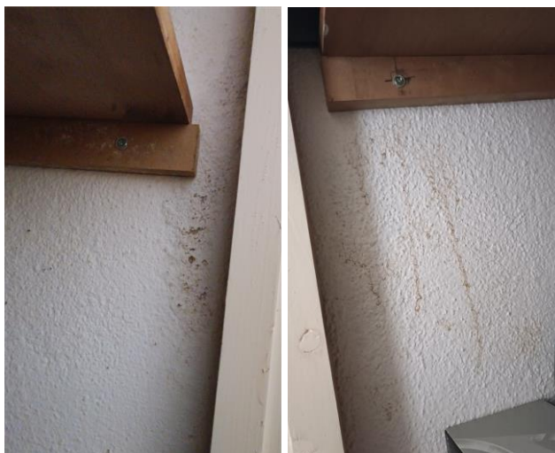
Figura 20 – Detalhes da parede
