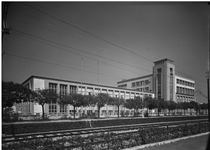
Figura 5 - Edifício da Antiga Standard Elétrica
