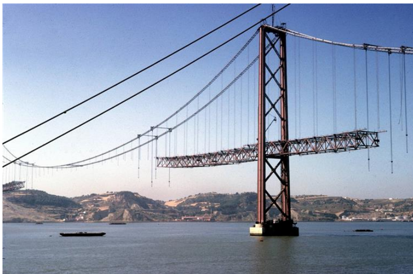
Figura 2 - Ponte 25 de Abril em construção
