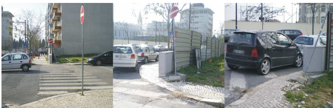
Figura 76: Atravessamento rebaixado mas inacessível, percurso Estrela – Docas
