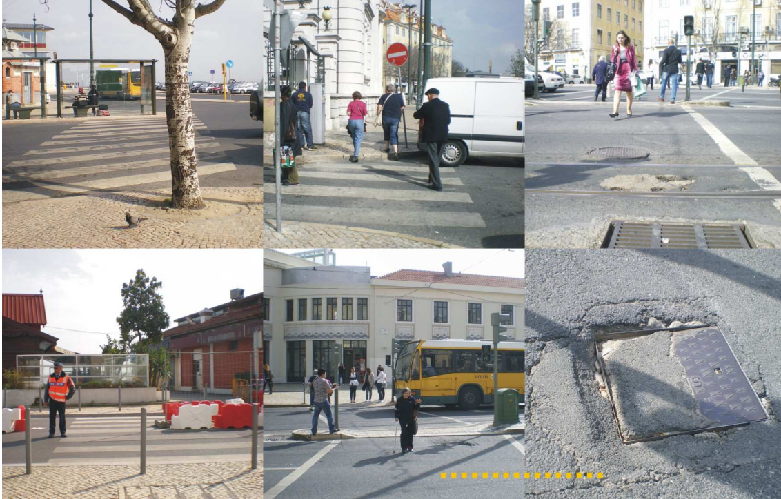
Figura 87: Obstáculos em passagens de peões, percurso Bairro Alto / Cais do Sodré
