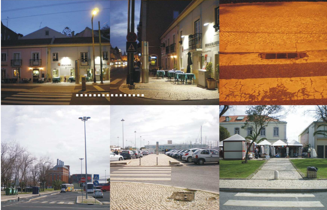
Figura 65: Existência de barreiras à acessibilidade em passagens de peões, percurso Belém
