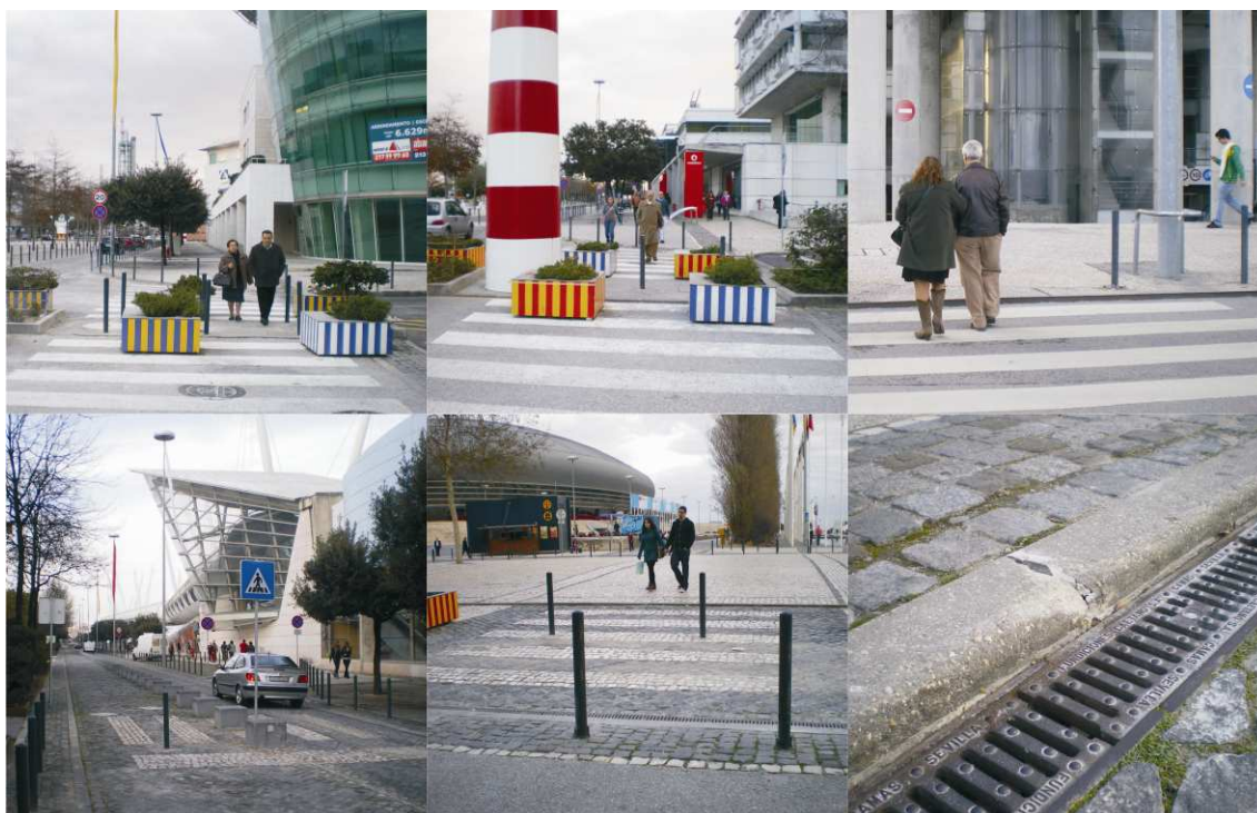
Figura 113: Barreiras à acessibilidade em passagens de peões, percurso Parque das Nações
