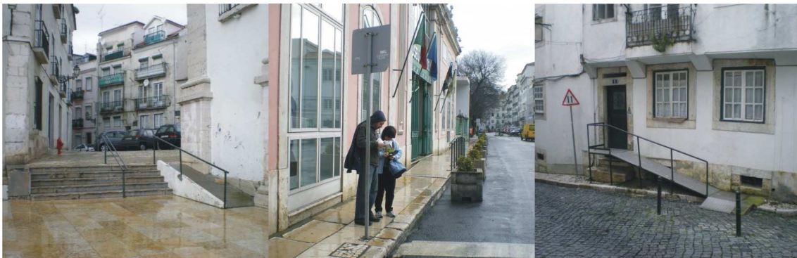
Figura 108: Minimização de alguns problemas de acessibilidade, percurso Mouraria - Alfama
