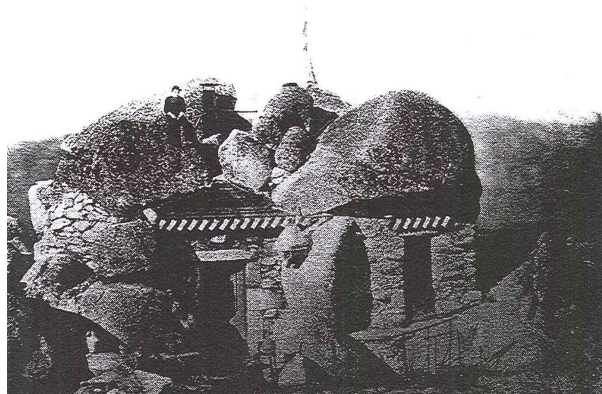
Serra da Estrela – Casa de César Henriques – Lado do Sul Fonte: Quatro dias na Serra da Estrela, p.4
