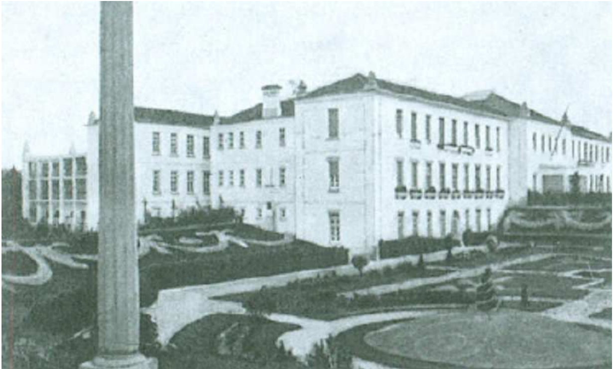
Sanatório dos Covões, em Coimbra.
