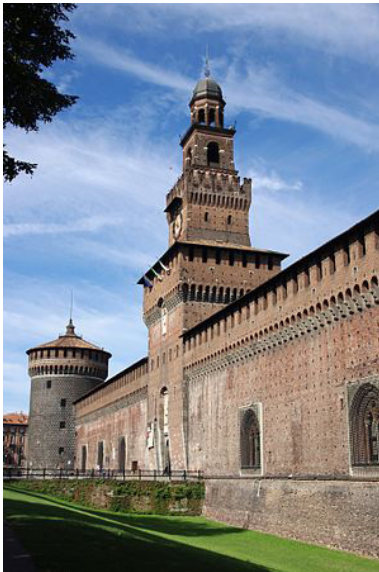
Fig.5 - Castello Sforzesco pós-intervenção por Luca Beltrami - Milão
