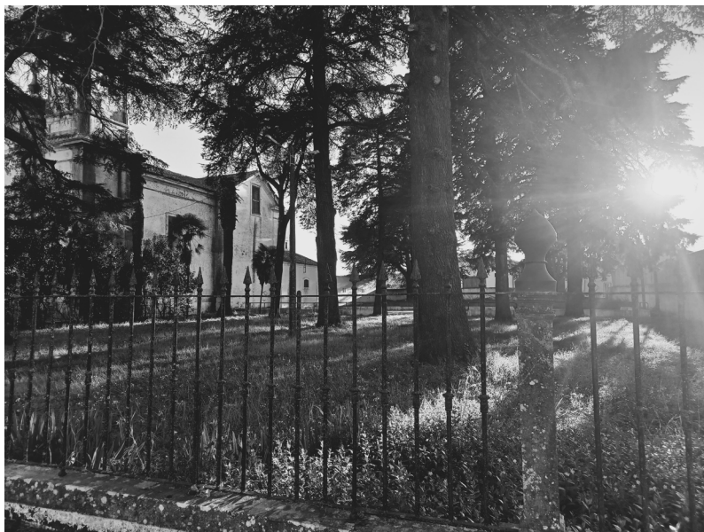
A degradação do espaço lateral (Norte) adjacente á Igreja da Lapa
