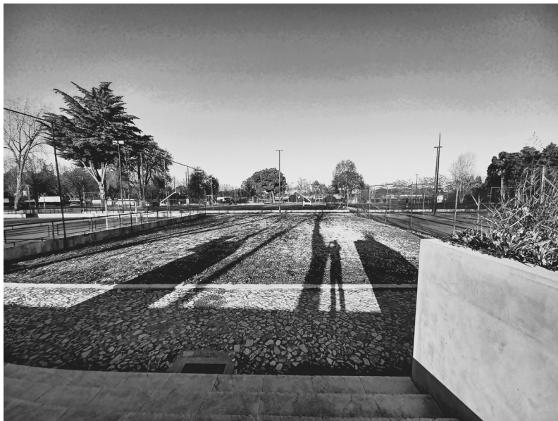
A degradação e diferenciação dos diferentes materiais de pavimento do campus desportivo
