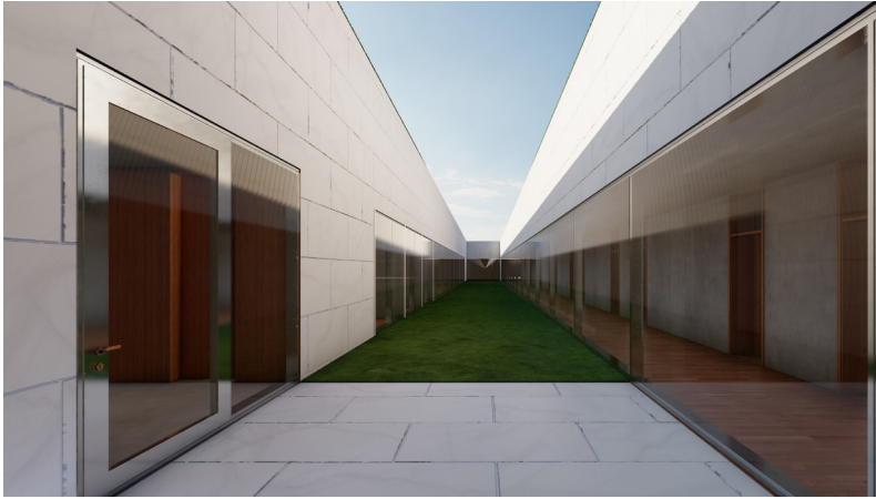
Fig.109 - O Vazio do Módulo de Administrativo/Aulas/Entrada e Ligação ao Corredor do Módulo de Dormir/Aulas
