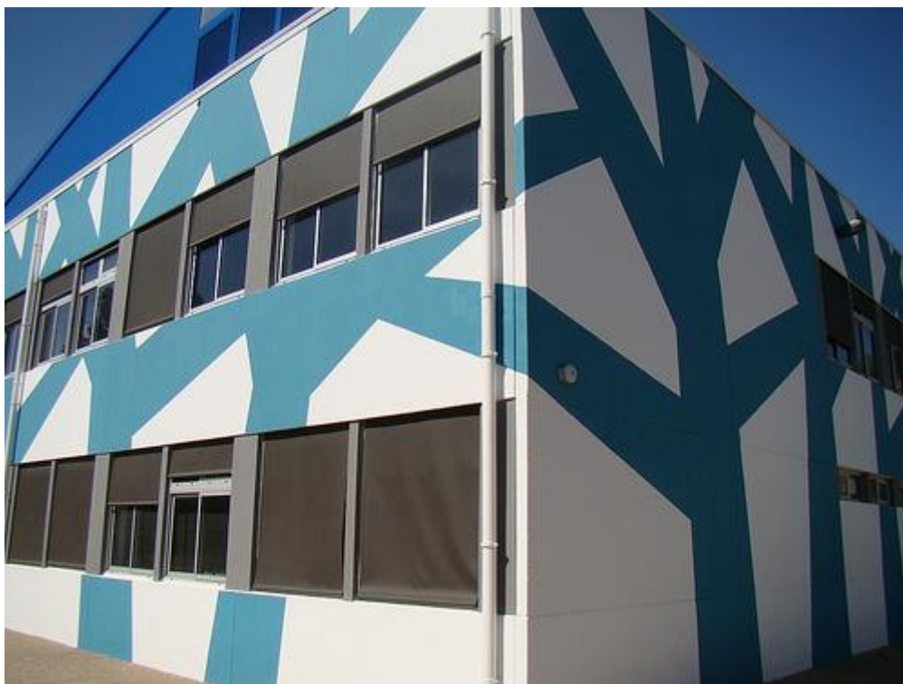
Figura 19: Salas de aula vistas do exterior.
