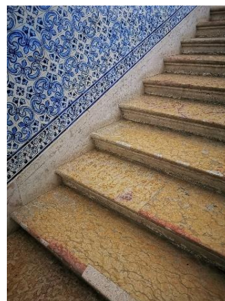
Figura 4.32b – Pormenor do revestimento de parede e pavimento| Fonte: Autora
