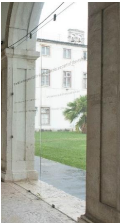
Figura 4.35. – Vidro instalado nas arcadas| Fonte: Autora
