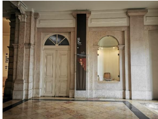
Figura 4.28. – Revestimentos, pavimento e porta existente no Átrio Principal| Fonte: Autora
