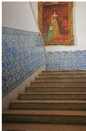
Figura 4.32a – Escadas com revestimentos e acabamentos originais| Fonte: Autora
