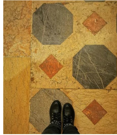
Figura 4.24. – Pavimento do Amphiteatro de Chimica em pedra Lioz e Mármore Preto | Fonte: Autora
