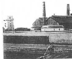
Conclui a nova fábrica de gás junto à Torre de Belém.
