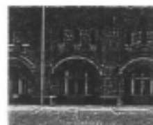
Central Eléctrico de Langerbrugge.
