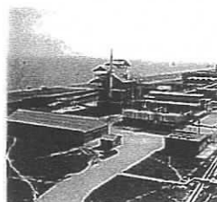
O funcionamento do edifício da alta pressão em regime de baixa pressão.
