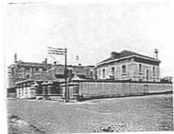
Construção do armazém e a casa do chefe na central da Junqueira.
