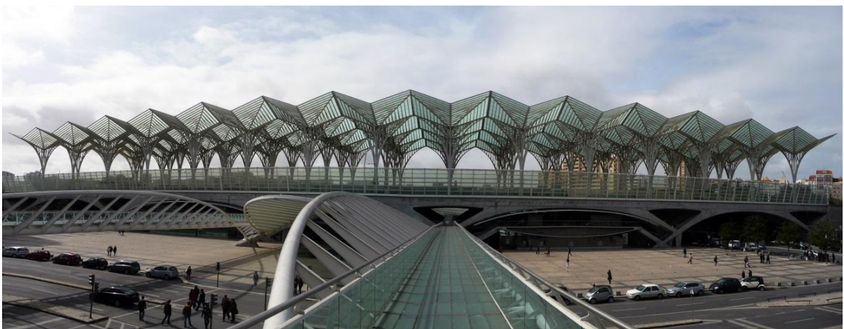
Figura 47: Acesso pedonal à Estação do Oriente (Fonte: http://www.timetogo.com/index.php?option=com_pti&view=pti&id=1504&Itemid=15&lang=pt )
