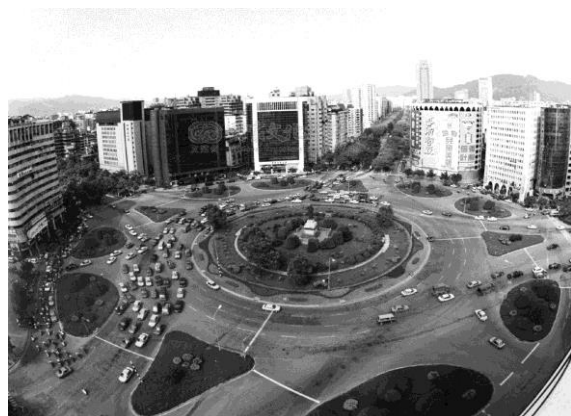
Figura 50: Rotunda existente antes da intervenção (Fonte: http://udconnect.net/lujiazui-pedestrian-walkway-shanghai/ )
