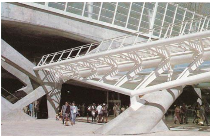
Figura 46: Estrutura tubular presente na ponte pedonal (Fonte: FINIESTRA 15, 1998. P. 76)
