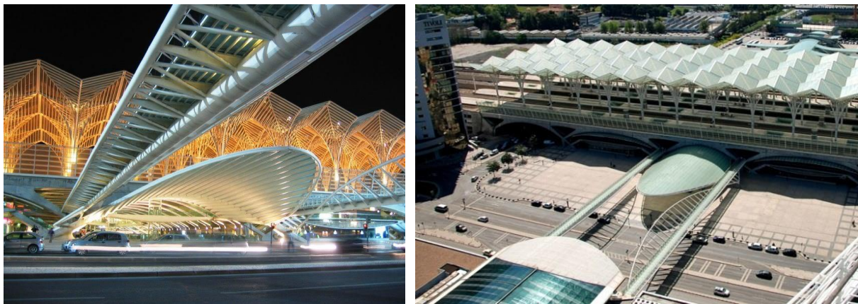
Figura 44: Ligação pedonal elevada entre a Estação do Oriente e o Centro Comercial Vasco da Gama. (Fonte: http://papodearquitectas.blogspot.pt/2013/05/estacao-do-oriente-calatrava.html )
