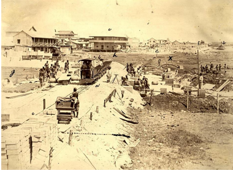
Figura 21: Construção do Caminho de Ferro
