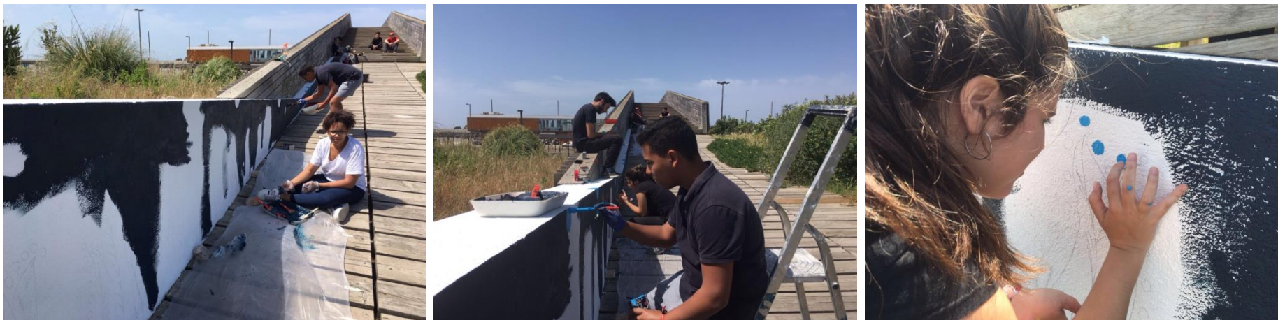
Figura 82 - Execução da pintura do muro (Fonte própria)
