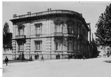
Construção do Palácio Adolf Lima Mayer, projeto do Arquitecto Nicola Bigaglia. Figura 6
