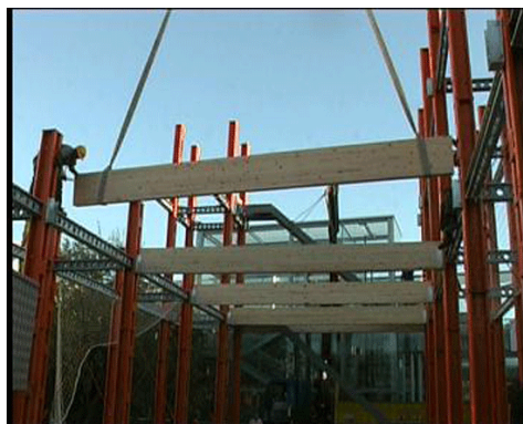
Figura 70 – Montagem da estrutura
