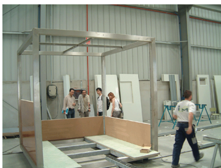
Figura 71- Montagem do módulo
