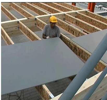
Figura 68- Aplicação do pavimento
