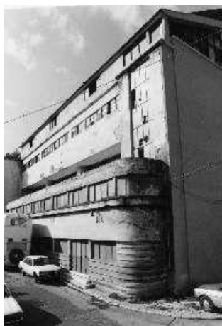
Figura 29 – Lateral sul após 1935
