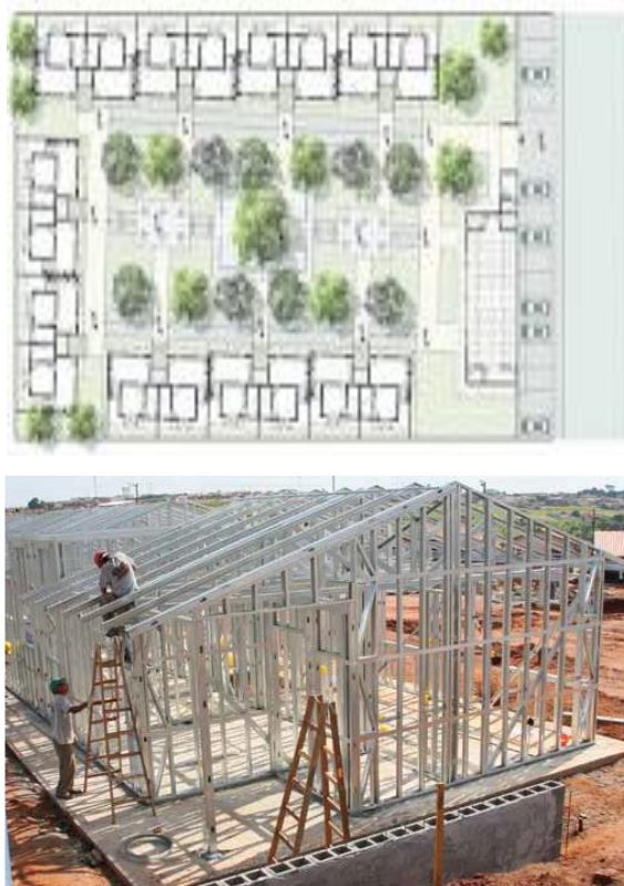
Figura 15 – Implantação do empreendimento “vila da Dignidade” em terrenos diferentes e construção casa sistema steel Frame Fonte: www.saopaulo.sp.gov.br
