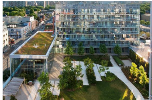
Figura 30 - Cobertura intensiva em Toronto projetada por arquitetos de diamante Schmitt, One Cole condomínios Sky Park. Fonte: < http://www.constructioncanada.net >
