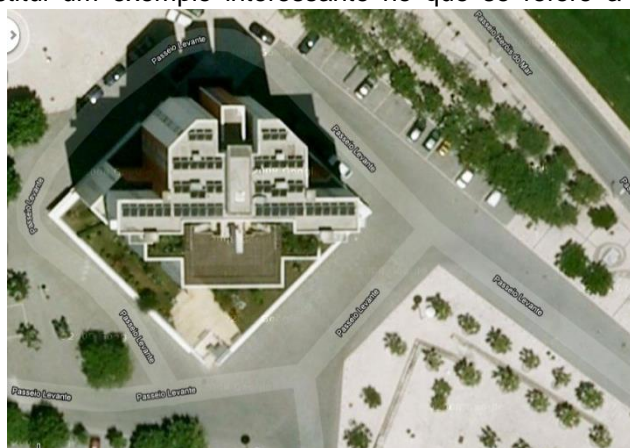
Figura 16 - Vista aérea da Torre Verde em Lisboa. Fonte: < https://maps.google.pt >
