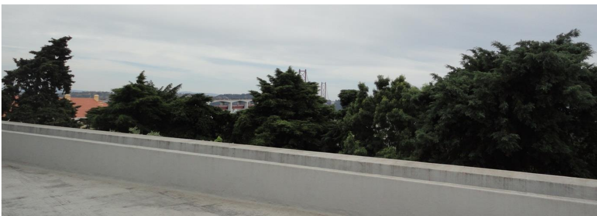
Figura 40 - Vista do terraço Sul
