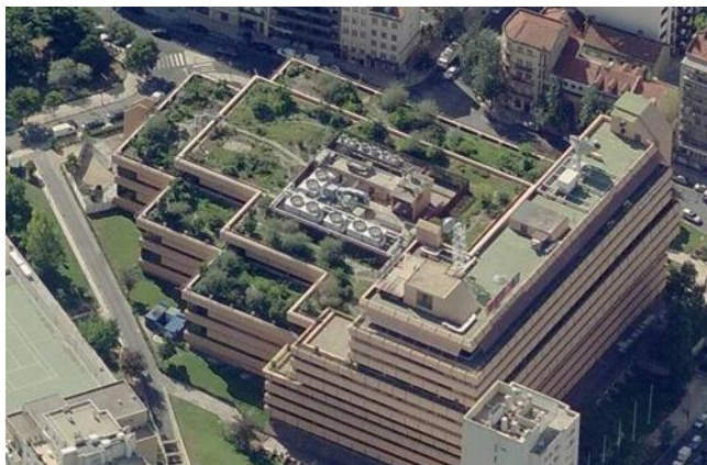
Figura 13 - Vista de cima do Edifício da Portugal Telecom em Picoas, Lisboa. Fonte: < http://i225.photobucket.com >
