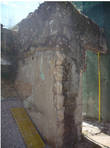
Imagem 267: Detalhe do cunhal existente na parede Poente que confina o pátio de entrada.
