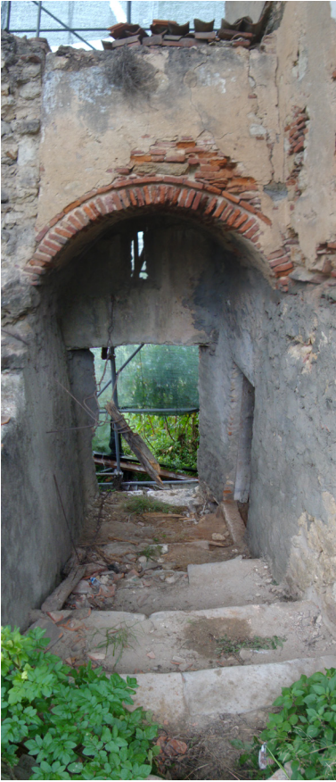
Imagem 301: Escadas exteriores contíguas ao anexo da cozinha. Por cima destas, elemento construtivo em arco de tijolo sobre as escadas que corresponde a um forno.
