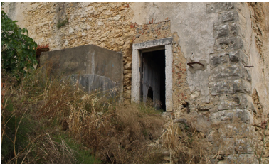
Imagem 265: Detalhe do cunhal entre a fachada poente e sul. Foto de José Aguiar.
