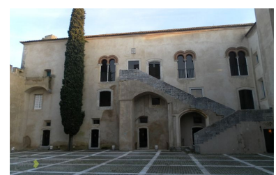
Imagem 153: Vista do pátio interior do Paço do Alvito.
