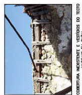
CHIMNEU ESTRUTURALMENTE DANIFICADO E PRESENÇA DE INSTAÇÃO NA BASE
