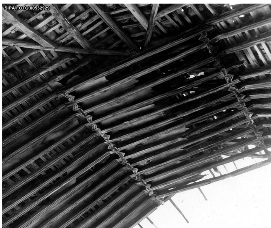
Imagem 270: Esquema de armação de perna e nível com rincão simples.
