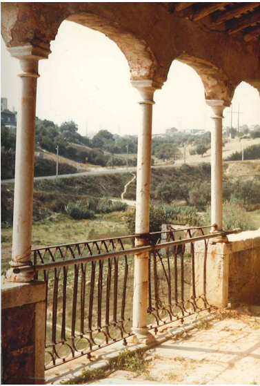
Imagem 228: Balaustrada de ferro e colunelos existentes na loggia do Palácio. Arquivo ADPAC.
