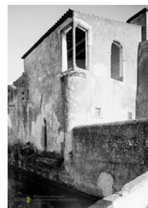
Imagem 187: Tanque de água no Solar de Água de Peixes.
