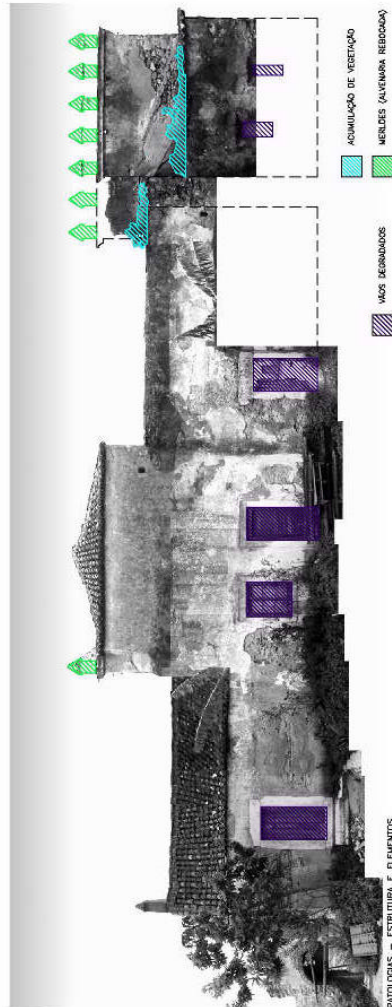
PATOLOGIAS - ALVENARIA E REBOCO
