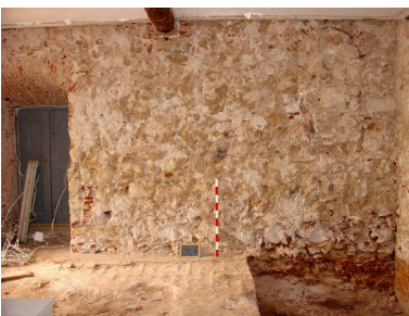
Imagem 120: Fotografia da parede nordeste, após a picagem de rebocos.
