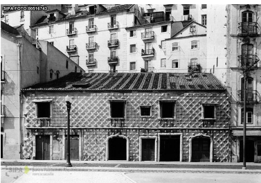
Imagem 193: Casa dos Bicos em 1964, apresentando a volumetria que restou após o terramoto.
