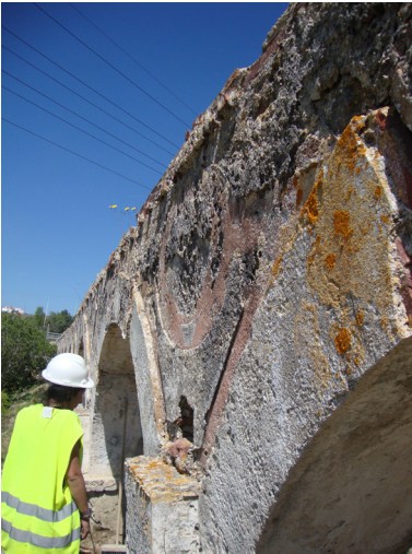
Imagem 281: Detalhe do Aqueduto. Marcação de reentrância na pedra. Para lá da mesma verifica-se um encaixe para barrote - Maio de 2019.
