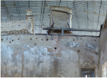
Imagem 273: Fachada interior nascente do salão central. Note-se, no topo da parede, a presença de uma frechal de madeira e dos agulheiros da carpintaria hoje desaparecida.
