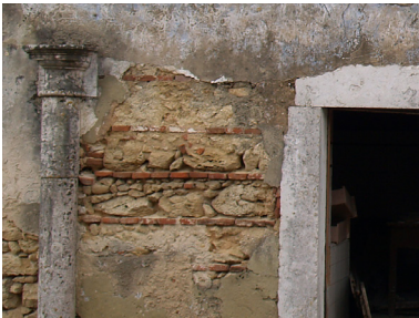
Imagem 259: Aparelho de alvenaria de pedra e alvenaria cerâmica. Guarnição da porta em cantaria de pedra. Foto de José Aguiar.
