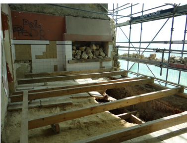
Imagem 255: Desmonte das abóbadas do piso -1, localizadas por baixo da cozinha do Palácio. Foto de Maria Ramalho.
