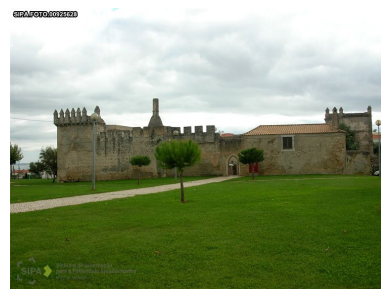
Imagem 161: Vista geral do Castelo de Pirescoxe em 2009.
