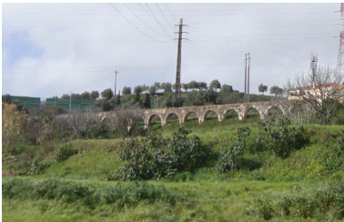
Imagem 238: Aqueduto de Cima - Fevereiro de 2018.
