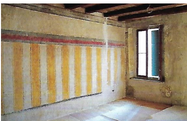
Imagem 70: Compartimento do Palazzo Bizzarrini após a intervenção, com as paredes e tecto descobertos.
