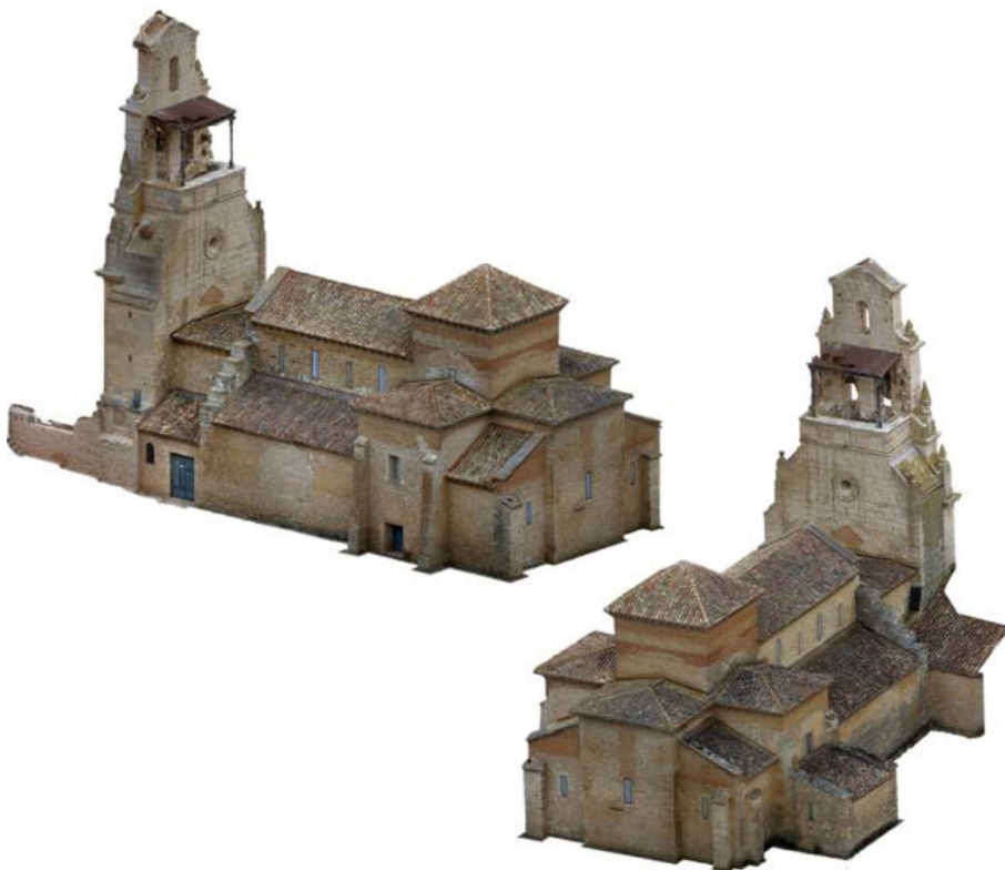
Imagem 55: Levantamento realizado por Fotogrametria da Igreja de San Cebrián de Mazote.
