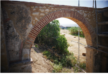
Imagem 280: Intervenção recente no arco de entrada para a Quinta, tendo sido o mesmo refeito. Foto de Maria Ramalho.
