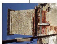
CHIMNEU ESTRUTURALMENTE DANIFICADO E PRESENÇA DE INSTAÇÃO NA BASE
