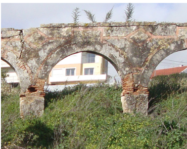
Imagem 239: Detalhe decorativo do Aqueduto de Cima - Fevereiro de 2018.
