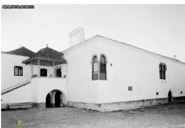
Imagem 185: Vista geral do exterior do Solar de Água de Peixes. Foto de 1949.
