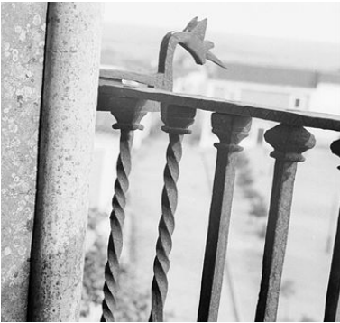
Imagem 155: Ferragens existentes numa varanda do Paço do Alvito. Os apoios da mesma à parede realizam-se através de dragões metálicos.
