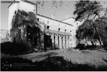
Imagem 169: Fachada nascente do Paço de Belas.
