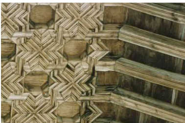
Imagem 275: Pormenor do tecto da nave central da Igreja Paroquial de Dois Portos, em Torres Vedras.
