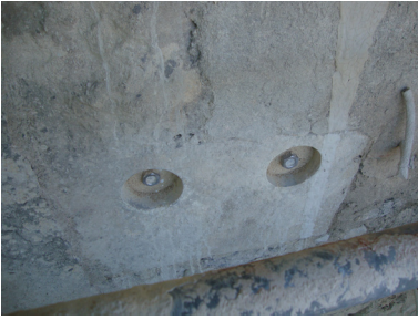
Imagem 253: Pregagens na parede exterior do Palácio.
