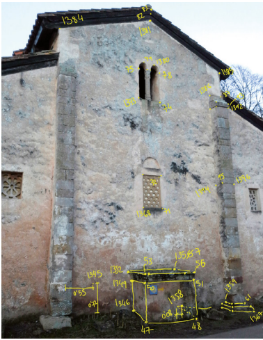
Imagem 56: Aplicação do método de levantamento através de Estação Total, com a representação dos pontos medidos.
