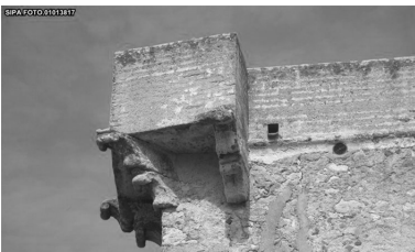
Imagem 140: Matacão na Torre da Camoeira. Foto de 2013.
