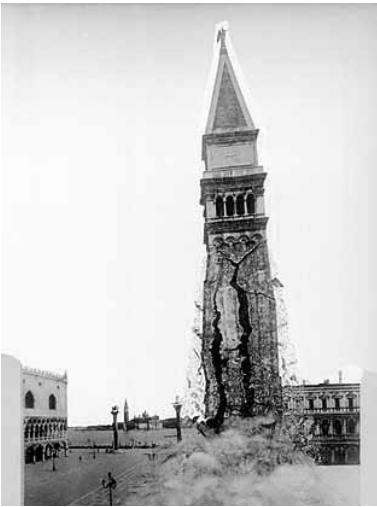
Imagem 20: Foto montagem retratando o colapso do Campanário em 1902.
