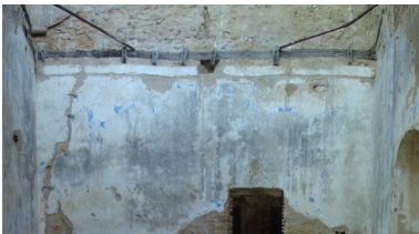
Imagem 274: Fachada interior norte da sala 2. Aqui podem ser encontrados os mesmos elementos de carpintaria que na imagem anterior.
