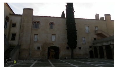
Imagem 152: Vista do pátio interior do Paço do Alvito.
