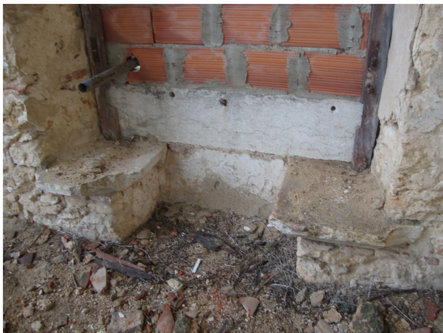
Imagem 244: Conversadeiras existentes nos vãos do Palácio. De notar o detalhe do desenho das mesmas na sua união com a parede. - esquerda.
