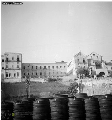
Imagem 207: Vista sul do Convento de São João de Deus.
