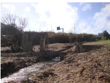
Imagem 240: Vestígios do Aqueduto de Baixo junto à ribeira - Fevereiro de 2018.
