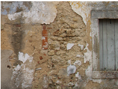
Imagem 260: Aparelho de alvenaria de pedra. Guarnição da janela em cantaria de pedra. Foto de José Aguiar.
