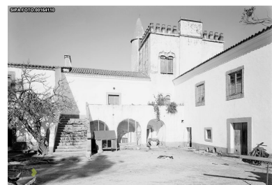
Imagem 137: : Vista da escadaria exterior sul da Torre da Giesteira.
