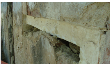
Imagem 261: Guarnição em pedra do vão original. Sobre a ligação entre a ombreira direita e a verga não existe grandes dúvidas. No entanto, a verga não assenta sobre a ombreira esquerda, visto esta ser inexistente, mas assenta sobre a parede em que se insere.
