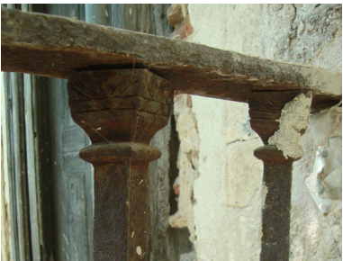
Imagem 248: Detalhe da guarda de ferro - Maio 2019.
