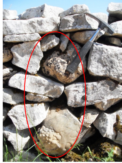
Fig. 60 – Nódulos botrioidais utilizados na construção de um muro.
