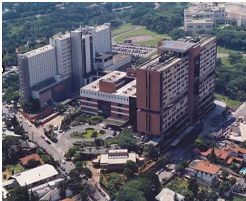
Figura 55. Construção da 2ª grande torre do Hospital Albert Einstein entre 1987 e 1994. Fonte: Vídeo institucional no Youtube 35
