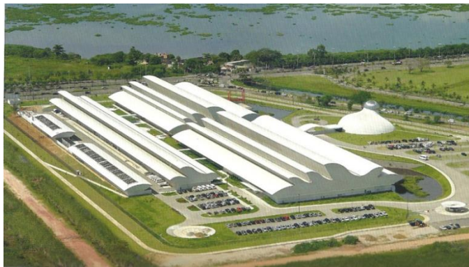
Figura 61. Hospital Sarah Rio de Janeiro. Fonte: Latorraca, 2010.
