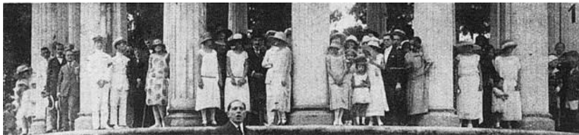
Figura 50 -Imagem do Pavilhão Vesta, ocupado por diversas pessoas, por ocasião da comemoração do juramento à bandeira pela primeira turma de escoteiros do Instituto Lauro Sodré, em 1924. Fonte: (FAU ITEC UFPA, 2016).
