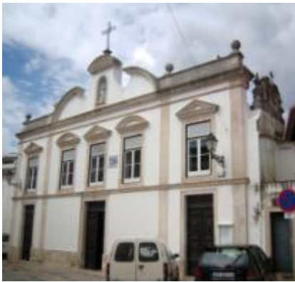
Fachada da Igreja da Misericórdia de invocação do Espírito Santo. Fotografia tirada a 13-05-2010.
