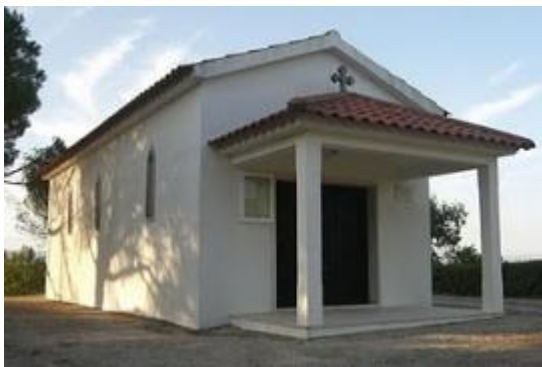
Fachada da capela de Nossa Senhora da Escusa. Fotografia tirada a 23-4-2011.
