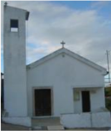
Fachada da Capela de São Gregório. Fotografia tirada a 23-4-2011.
