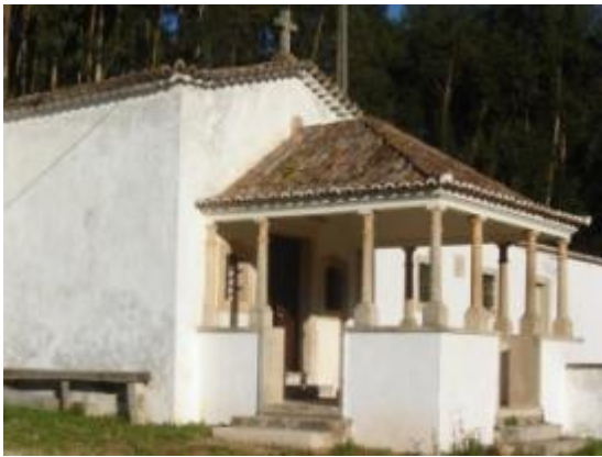
Fachada da capela de Nossa Senhora da Luz. Fotografia tirada a 16-12-2010.
