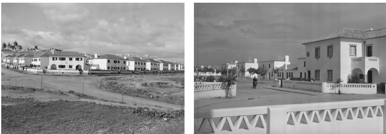
Figura 35 – Vistas da zona de urbanização nº1, ano desconhecido (estima-se década de 50) (fonte: AFCME)
