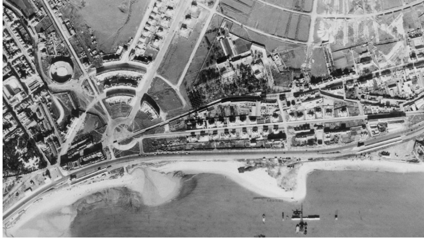
Fig. 26 -Vista aérea da Praia de Pedrouços no início das obras da doca - ARQUIVO DOS PORTOS DE LISBOA, SETÚBAL E SESIMBRA
