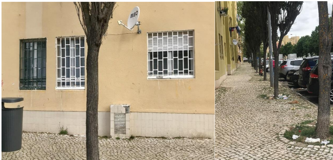
Figura 16 - Janelas de um edifício do Bairro Novo situadas no nível 0 com grades; Passeio sem limpeza urbana. Fotos tiradas em 3 de abril de 2019 e 17 de maio de 2019.
