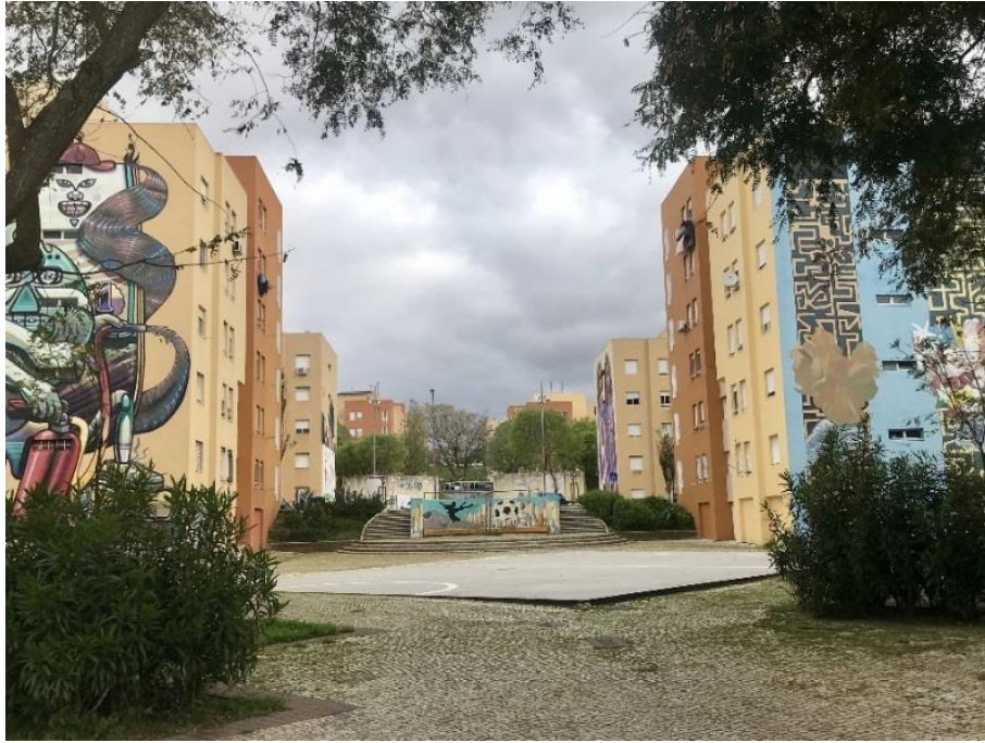
Figura 15 - Espaço público arborizado situado no Bairro Novo. Foto tirada em 3 de abril de 2019.
